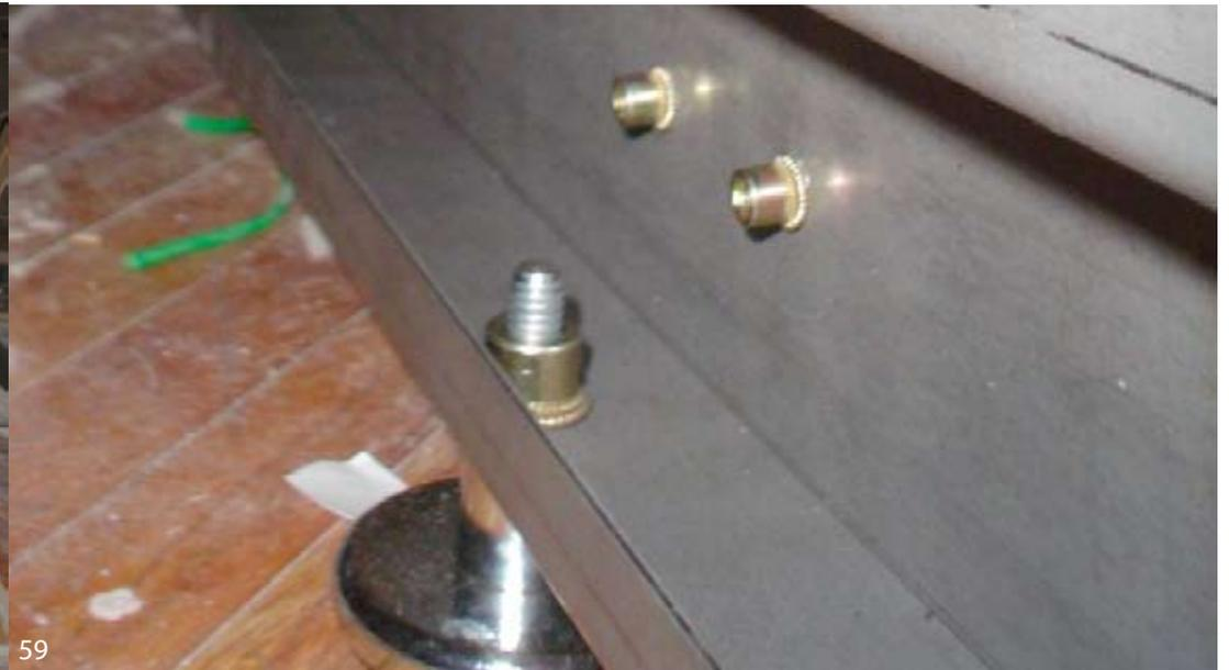
Cada doblez en el desarrollo del perfil tiene un objetivo. Da resistencia, tiene un área para atornillar niveladores, un área para atornillar molduras, un escalón que recibe al vidrio, el cual puede ir atornillado en su zapata para vidrios de carga, o puede ser deslizado por rieles remachados, y por último, delimita el bastidor de madera de los vidrios.
