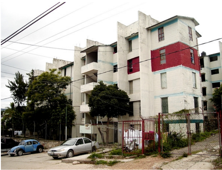
Foto 14. Edificio de 5 niveles. Unidad habitacional Héroes de Guerrero, Chilpancingo, Gro. Foto: Alberto Tello. Fecha: 26/07/07
