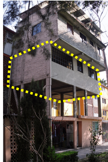
Foto 53. Vista de la fachada posterior con ampliación. Foto: Alberto Tello. Fecha: 28/09/09
