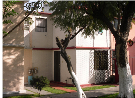
Foto 32. Vivienda unifamiliar en el sector VIII, que conserva rasgos originales del prototipo. Foto: Alberto Tello. Fecha: 17/12/09
