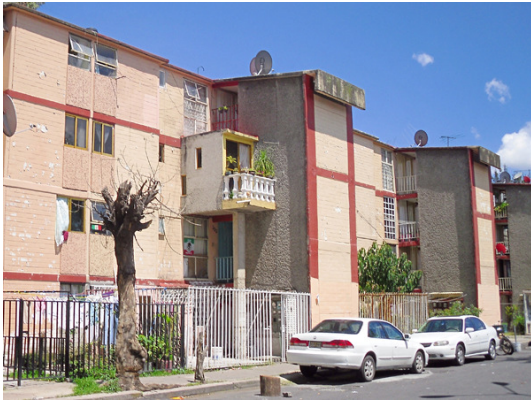
Foto 60. Vista general de edificios y volumen de ampliación. Foto: Alberto Tello. Fecha: 28/09/09
