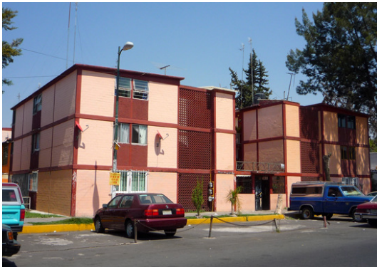
Foto 33. Edificio multifamiliar aislado, con cuatro departamentos por nivel y cubo de escaleras interior, en el sector VII. Foto: Alberto Tello. Fecha: 27/02/10
