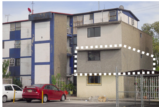
Foto 50. Vista general del volumen de la ampliación. Foto: Alberto Tello. Fecha: 08/12/09
