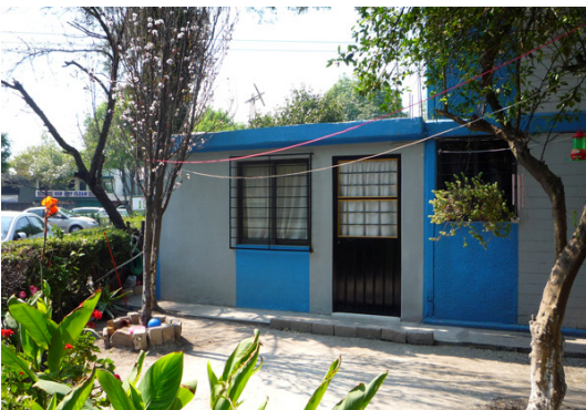
Foto 39. Vista de la fachada principal del anexo. Foto: Alberto Tello. Fecha: 27/02/10
