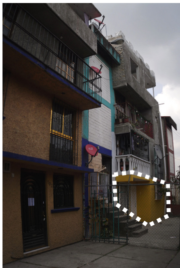
Foto 47. Vista de la fachada principal con ampliaciones y modificación de acceso al cubo de escaleras. Foto: Alberto Tello. Fecha: 17/12/09
