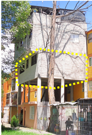
Foto 52. Vista de la fachada posterior con ampliación. Foto: Alberto Tello. Fecha: 28/09/09
