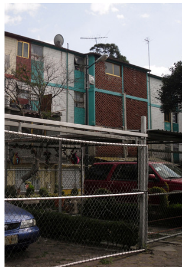
Foto 48. Vista de la fachada posterior del edificio y jaulas de estacionamiento. Foto: Alberto Tello. Fecha: 17/12/09
