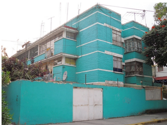
Foto 7. Edificio multifamiliar. Unidad Modelo, 1954. Foto: Alberto Tello. Fecha: 27/11/09
