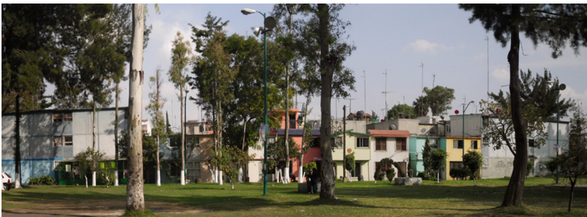
Foto 30. Panorámica de un área verde en el sector VII en donde se puede observar al fondo una línea de viviendas unifamiliares con una serie de modificaciones realizadas. Foto: Alberto Tello. Fecha: 17/12/09
