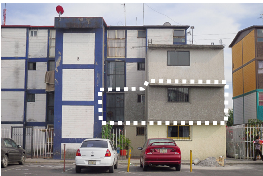
Foto 49. Vista parcial de la fachada principal con ampliación. Foto: Alberto Tello. Fecha: 08/12/09
