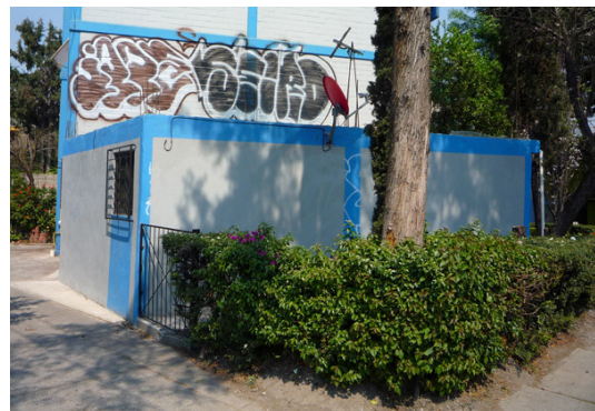
Foto 40. Vista de la fachada lateral del anexo. Foto: Alberto Tello. Fecha: 27/02/10
