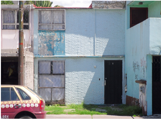
Foto 31. Vivienda unifamiliar en el sector VII, que conserva la fisonomía original del prototipo. Foto: Alberto Tello. Fecha: 28/09/09
