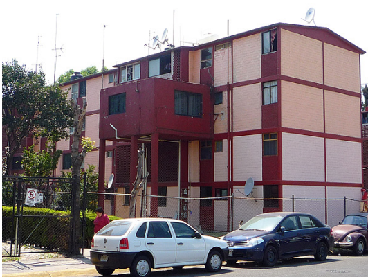
Foto 54. Vista general de la fachada posterior con ampliación. Foto: Alberto Tello. Fecha: 27/02/10
