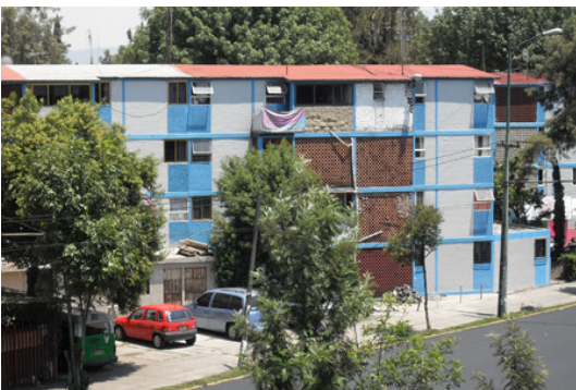
Foto 37. Vista general de la fachada posterior del edificio. Foto: Alberto Tello. Fecha: 30/07/09
