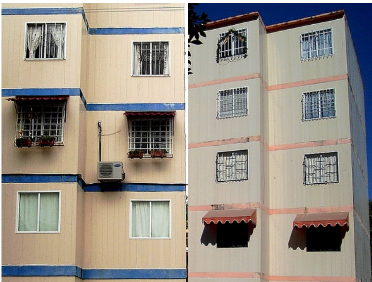
Foto 13. Edificios de 5 niveles. Unidad habitacional Villa Huacapa, Chilpancingo, Gro. Foto: Alberto Tello. Fecha: 25/07/07
