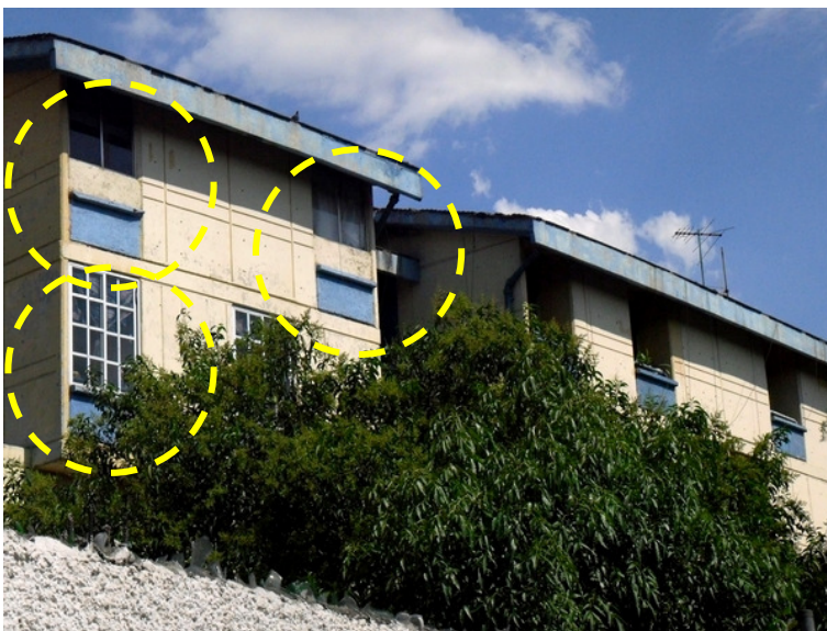
Foto 25. Edificio de 5 niveles. Conjunto habitacional Xochinahuac, Azcapotzalco, México DF. Foto: Alberto Tello. Fecha: 07/08/09
