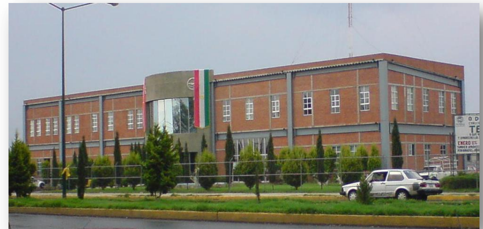
FOTO 24; Fachada de ODAPAS
