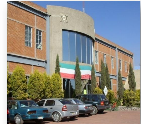
FOTO 23; Sección De la fachada de ODAPAS
