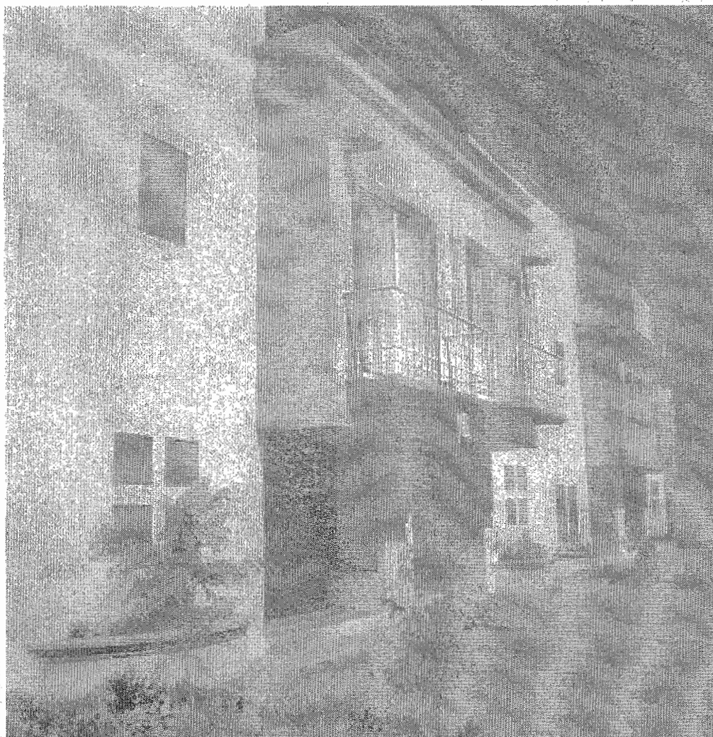
(Fig. 258).- Fachada principal de casa tipo, en Conjunto Residencial La Gloria, Cd. de Qro.
