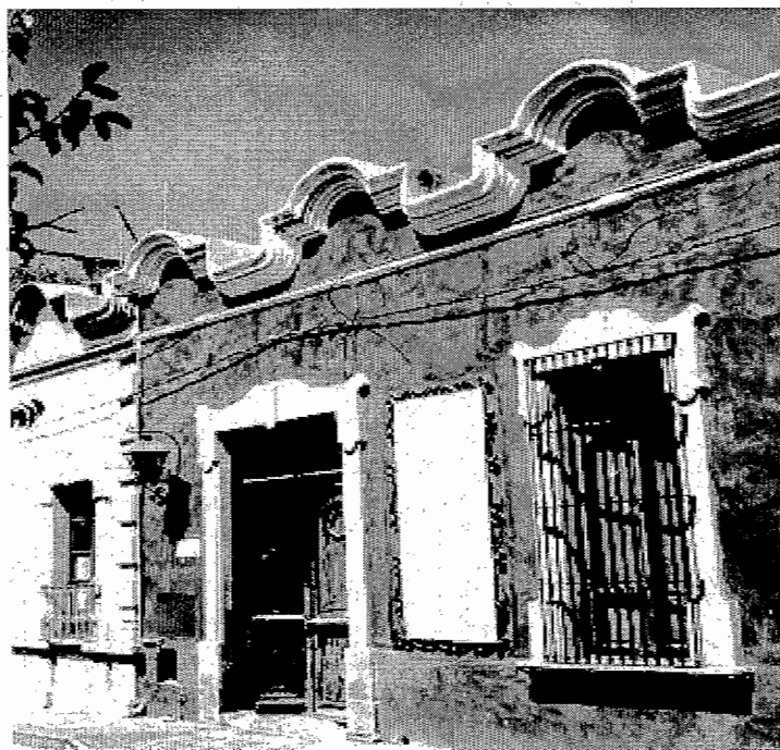
(Fig. 142).- Cornisa rica en molduras mixtilínea, en donde los perfiles son de un relieve profundo (entablamiento) provocando el manejo del claroscuro propio del estilo barroco (luz y sombra); casa habitación, ubic. en 16 de Sept. No.67, Centro Histórico, Qro.
