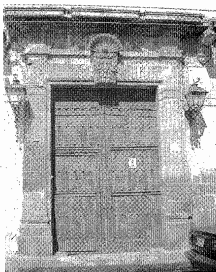
(Fig. 133).- Enmarcamiento (jambas) a base de cantera labrada con molduras sencillas, la jamba es continua después del dintel hasta la cornisa, incluye basa; la cornisa con molduras sencillas y sobresalientes del paramento de la construcción.
