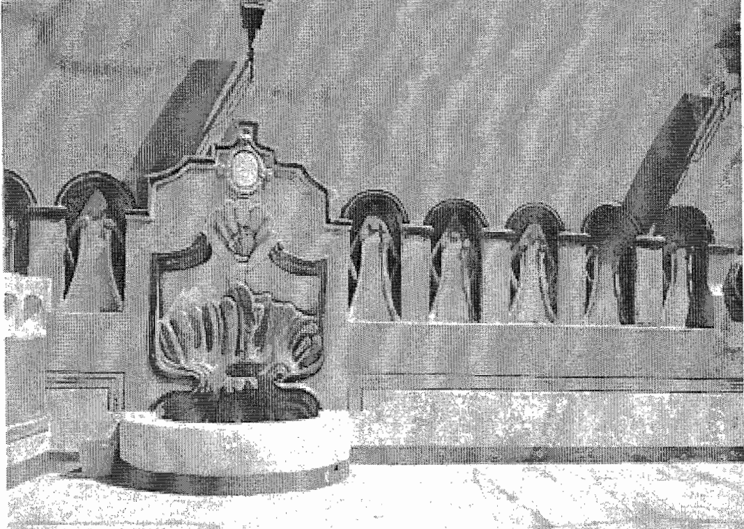
(Fig.168).- Fuente en patio interior. La decoración del conjunto está ricamente armonizado con los elementos que la integran: arcos, cornisa mixtilínea, molduras sencillas, conchas, escudos, guardapolvos, texturas de los materiales, color.
