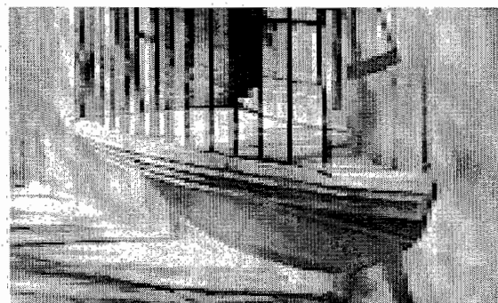
(Fig. 187).- Balcón con guardamalleta sencilla y remates con perfiles moldurados.
