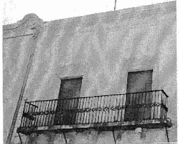
(Fig. 140).- Cornisa terminada en argamasa con molduras sencillas, el remate del pretil está terminado en argamasa y pintura de color.
