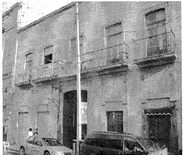
(Fig. 120).- Planta dos niveles. Portón central o Izq. o der. Con ventanas laterales (izq. ó der.) y superiores. Cd. de Qro.
