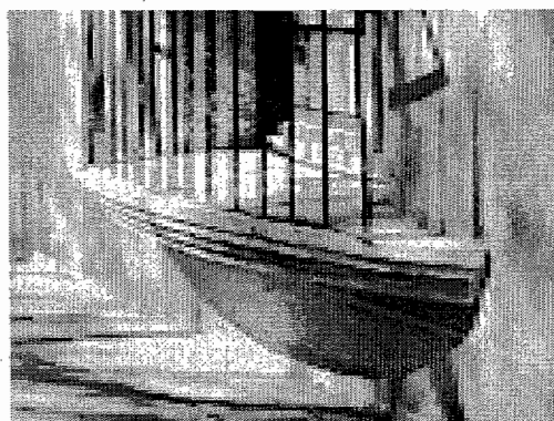
(Fig. 161).- Casa del Faldón, ubicada en la otra banda del Río. Qro.
