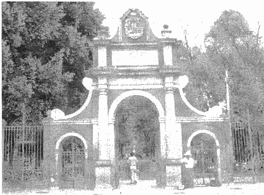
(Fig. 252).- Portal Monumental de la puerta de acceso norte de la Alameda, Cd. de Qro.- El orden toscano de las columnas se integran a los elementos barrocos como el roleo, la cornisa con entablamentos sobresalientes con ricas molduras tipo almohadillón, el arco de medio punto, los remates integrados al friso que ostenta el escudo de la muy noble y leal Cd. de Qro. enmarcado con cornisa tipo mixtilínea sobresaliente, manejando con ello el claroscuro de la luz y sombra, la textura del aplanado es lisa, el herraje es simple.
