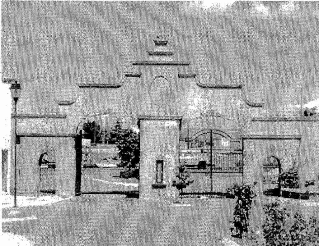
(Fig. 256).- Acceso principal al conjunto habitacional, visto desde el interior. Qro.
