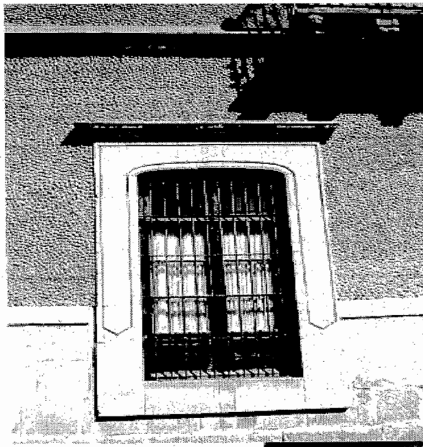
(Fig.145).- Textura rugosa, elaborada en argamasa y color, siendo una característica del barroco el empleo de la argamasa.
