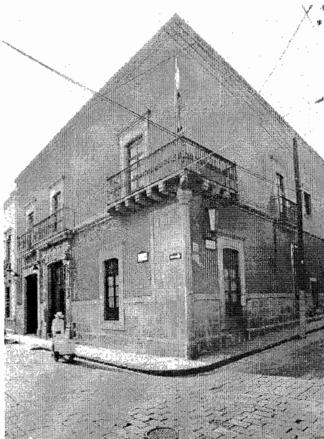
(Fig. 97).- Fachada en contra-esquina, casa del Conde de Sierra Gorda, Cd. de Qro.
