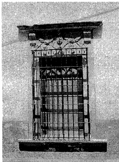
(Fig. 132).- Jambas de Cantera y remate de ventana con cornisa sobresaliente, incluye mensulas de cantera tipo roleos y hojas de guirnaldas en el dintel, el herraje de la ventana es de fierro forjado.
