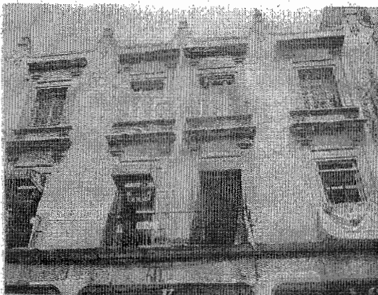
(Fig. 215).- Edificio.- Francisco I Madero 68 esq. Calle de Palma Centro Histórico de la Cd. de México
