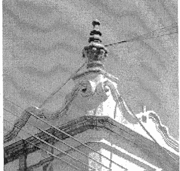
(Fig. 137).- remate de pretil con cornisa mixtilínea y remate de pináculo, integración con cornisa lineal rica en molduras y entablamientos sobresalientes, Casa de la Marquesa, Cd. de Qro.
