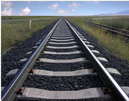
Mantenimiento de Vía
