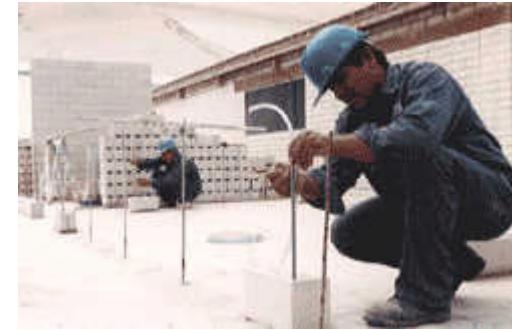
IMAGEN 36.Desplante de muro
