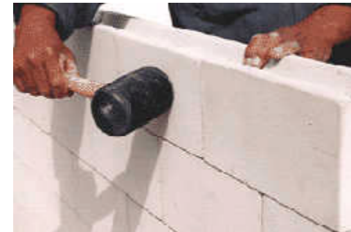
IMAGEN 49. Colocación de bloques
