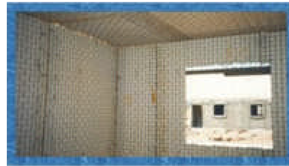
IMAGEN 22. Vanos en muro
