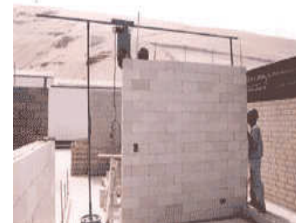
IMAGEN 52. Alzado de muro
