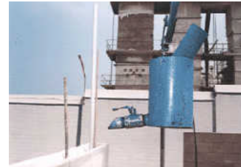
IMAGEN 53. Colado en muro
