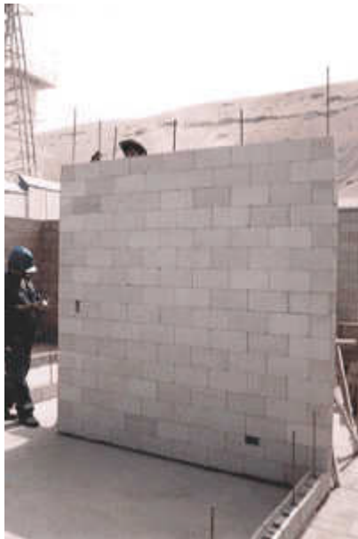
Vista exterior del muro terminado
