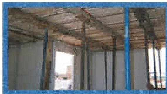
IMAGEN 20. Cimbra en losa
