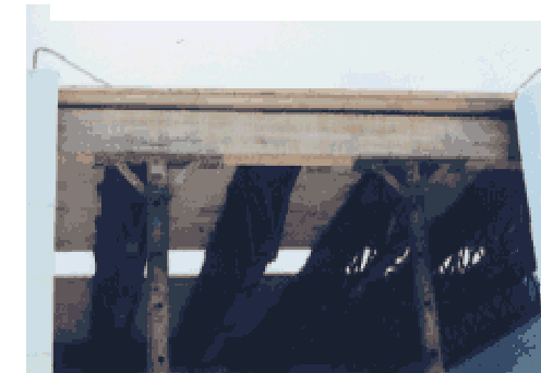
IMAGEN 55. Cimbra en losa
