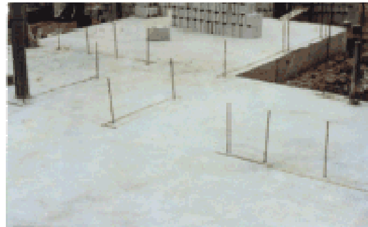
IMAGEN 35. Desplante de muro
