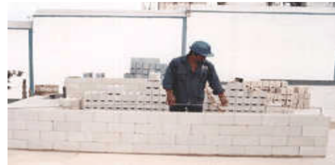
IMAGEN 39. Nivelación de muro
