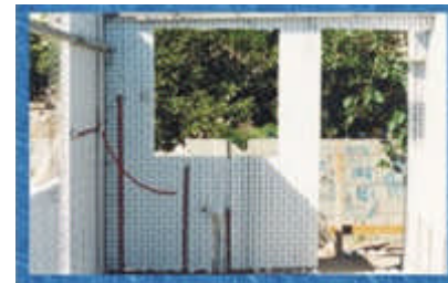
IMAGEN 25. Vanos en muro
