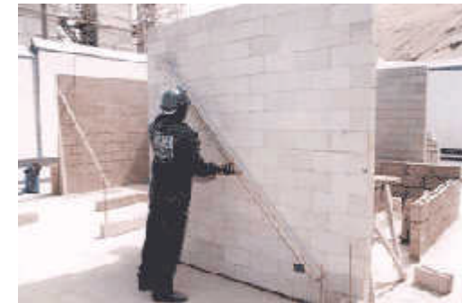
IMAGEN 48. Nivelación de muro
