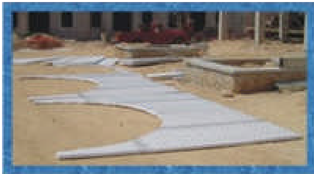
IMAGEN 21. Habilitado de paneles
