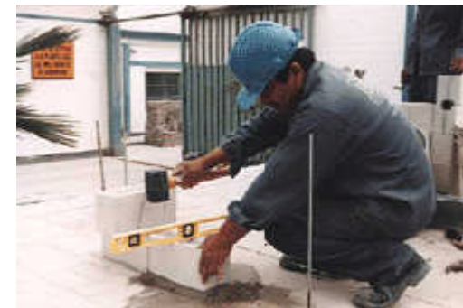
IMAGEN 37. Nivelación de muro
