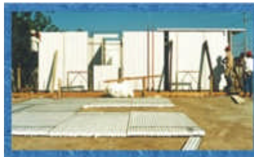
IMAGEN 19. Armado de muros
