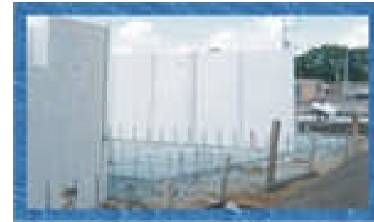
IMAGEN16. Anclaje de muros
