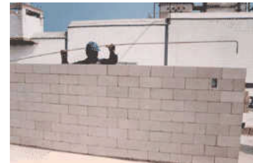
IMAGEN 46. Colado de muro
