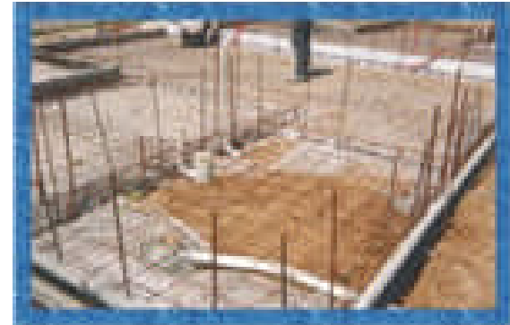
IMAGEN 14. Losa de cimentación
