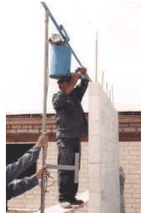
IMAGEN 51. Colado en muro
