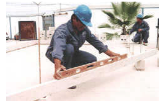
IMAGEN 38. Trazo de muros
