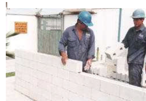
IMAGEN 44. Colocación de bloques
