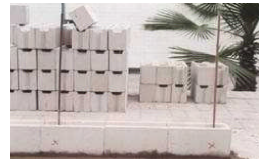
IMAGEN 43. Anclaje de muro
