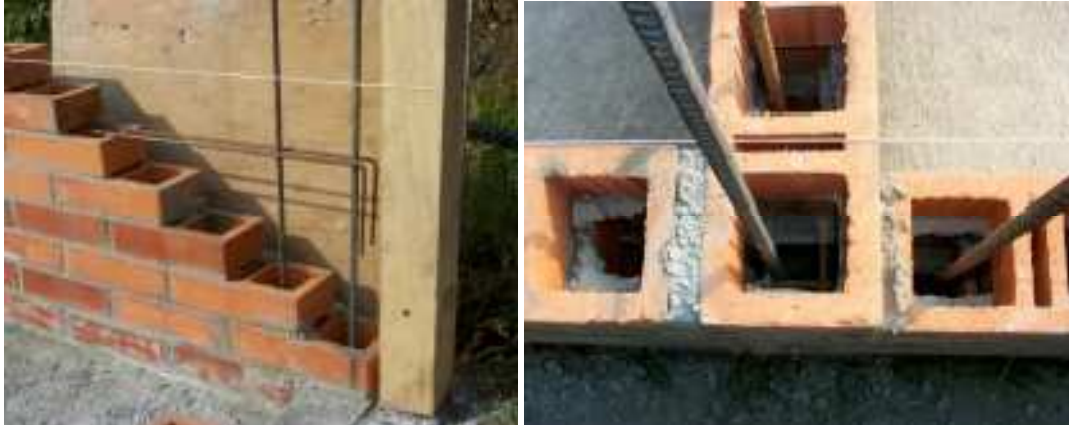
Figura 2.7.- Detalle de piezas huecas con refuerzo interior.
