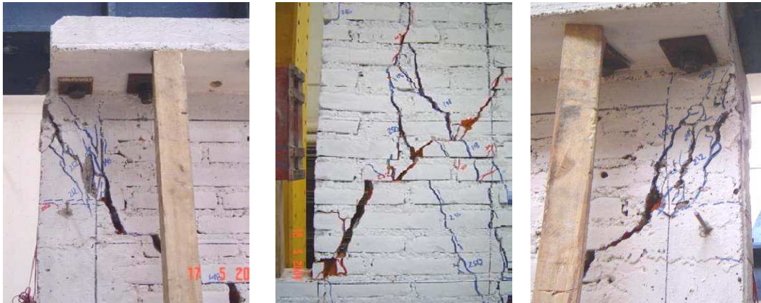
Figura 4.9.- Daño en castillos y en el panel de mampostería.
