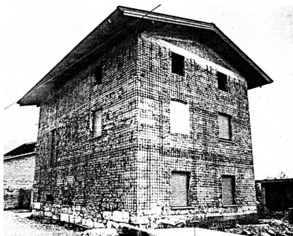
Figura 4.6.- Encamisado con mallas metálicas.
