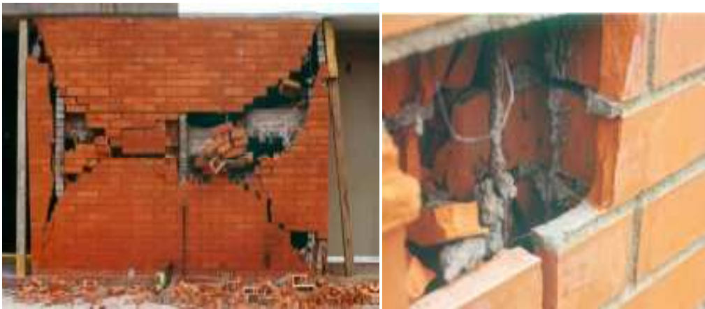
Figura 2.8.- a) Daño en muros de mampostería con refuerzo interior (Shultz, 1994); b) Fallas en muros de mampostería con refuerzo interior deficiente (Alcocer y otros, 1999).
