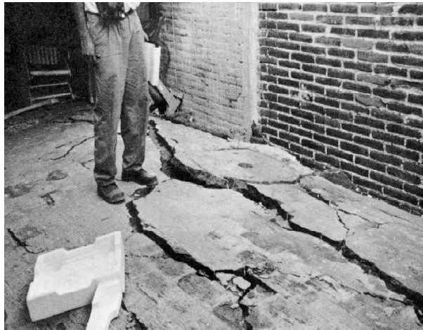
Figura 2.6.- Asentamiento de debido al fenómeno de licuación de arenas (López y Teshigawara, 1997)
