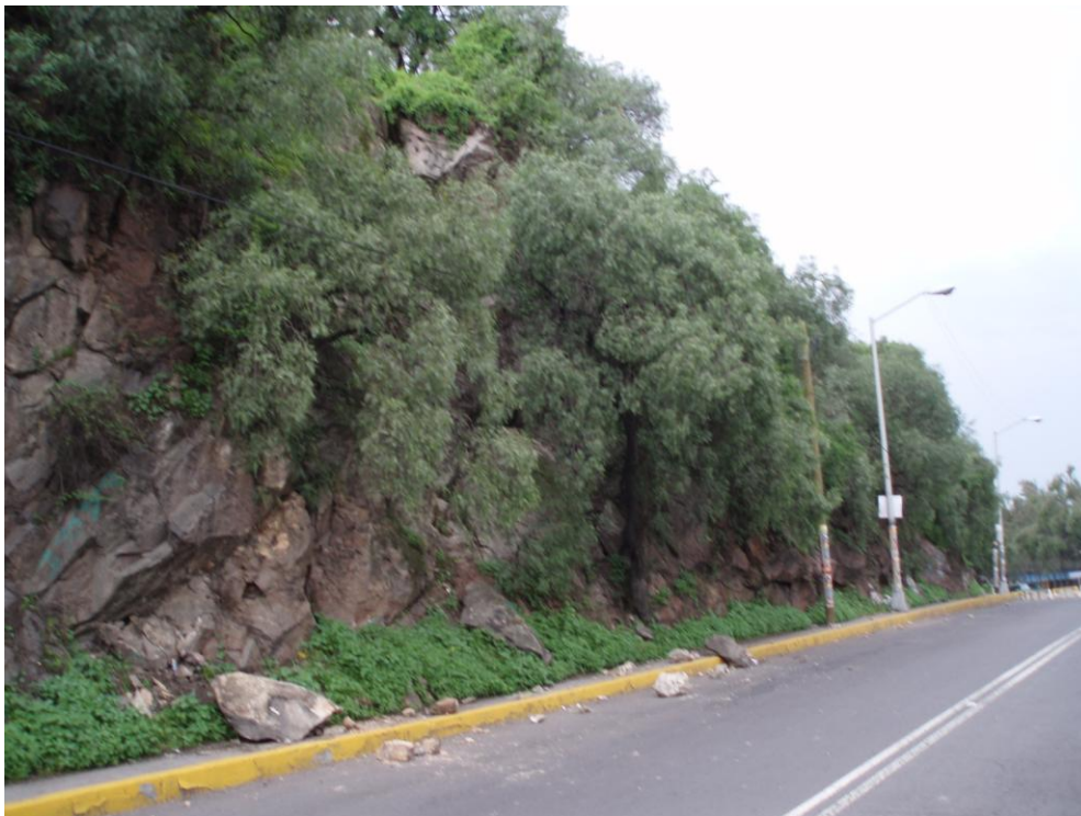
Figura 2. Alto riesgo que presentan los caídos de roca en la vialidad de Verano.
