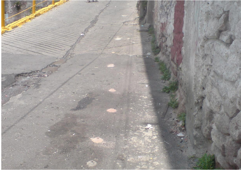
Figura 13. Barrenos realizados en la avenida de Otoño casi esquina con Palma, para la realización del Sondeo Eléctrico Vertical, SEV-5.
