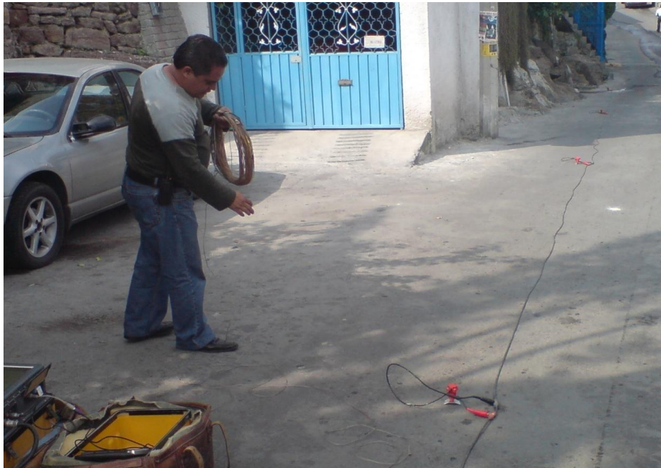
Figura 18. Colocación del cable de disparo durante la realización del Tendido de Refracción Sísmica, TRS-1, en la avenida de Huitzilopochtli.
