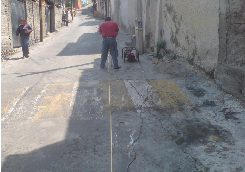
Figura 11. Se emplea cinta métrica para medir la distancia desde el centro del SEV hasta la posición donde se debe perforar el terreno para hincar los electrodos en avenida Otoño
