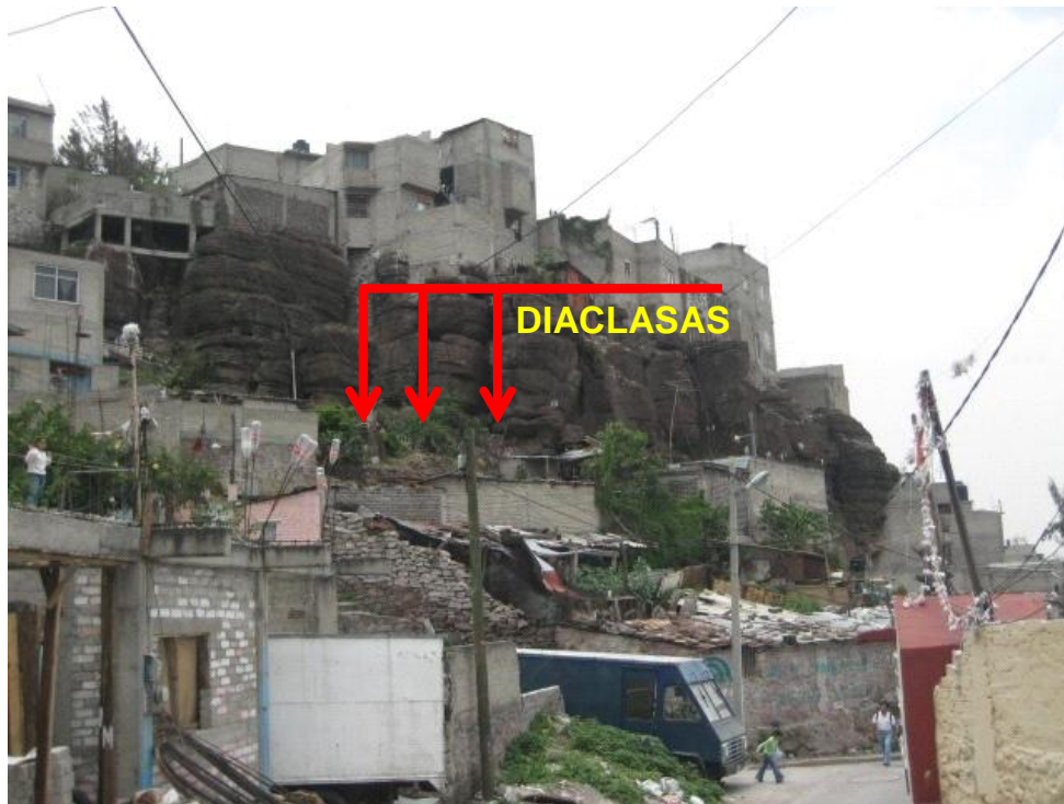
Figura 8. Vista general del escarpe presente en la manzana 16. Nótese las diaclasas con echado ligeramente macizo adentro, que concurre sobre la avenida de Otoño.
