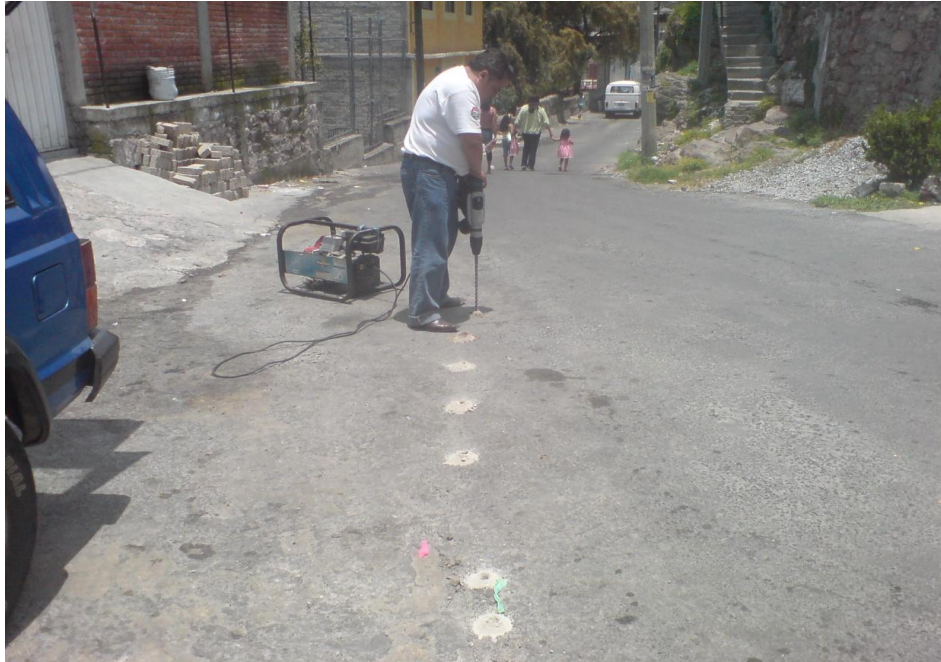
Figura 9. Para realizar los Sondeos Eléctricos Verticales (SEV), es necesario barrenar el pavimento, con el objetivo de que los electrodos de potencial y corriente se encuentren en contacto directo con el terreno natural. SEV-1, esquina de Huitzilopochtli y Verano.
