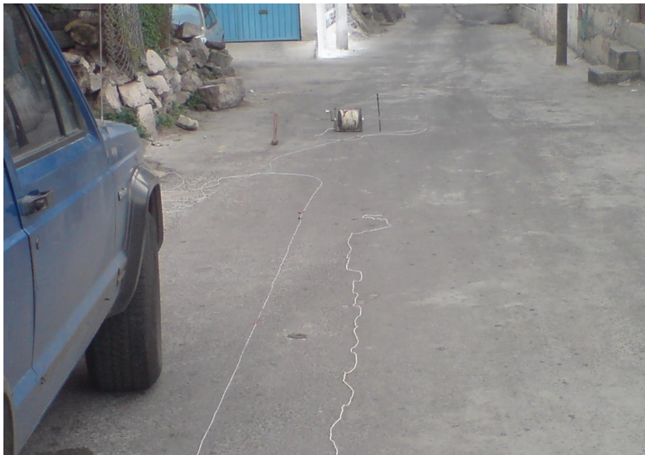
Figura 10. Colocación de electrodos dentro de los barrenos perforados, para la realización del Sondeo Eléctrico Vertical (SEV-2), sobre la avenida Huitzilopochtli.
