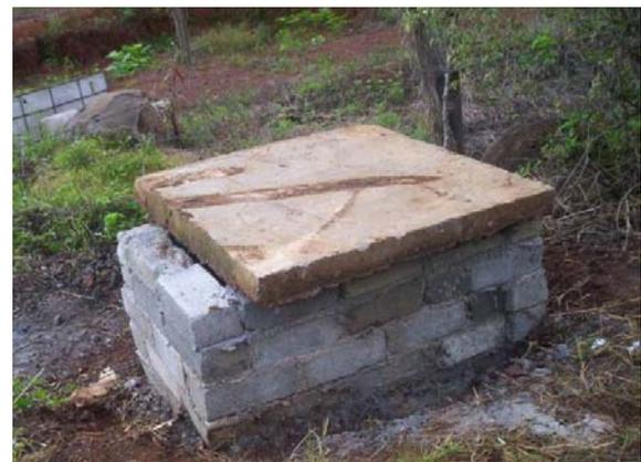
Figura 3.12 Arriba izquierda paso de la línea conducción por alcantarilla de la Supercarretera Siglo XXI. Y arriba derecha y abajo se muestran las Condiciones actuales en las que se encuentran registros de válvulas de admisión y expulsión de aire.
