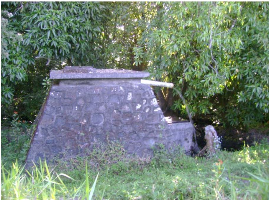
Figura 3.8 Fotografía del tanque que regula el gasto antes de la conducción.
