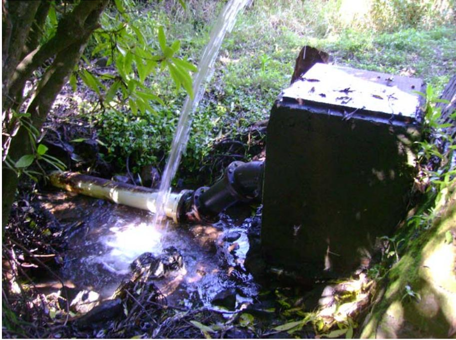
Figura 3.9 Fotografía de la caja de válvulas (de control y expulsión de aire) al inicio de la conducción.
