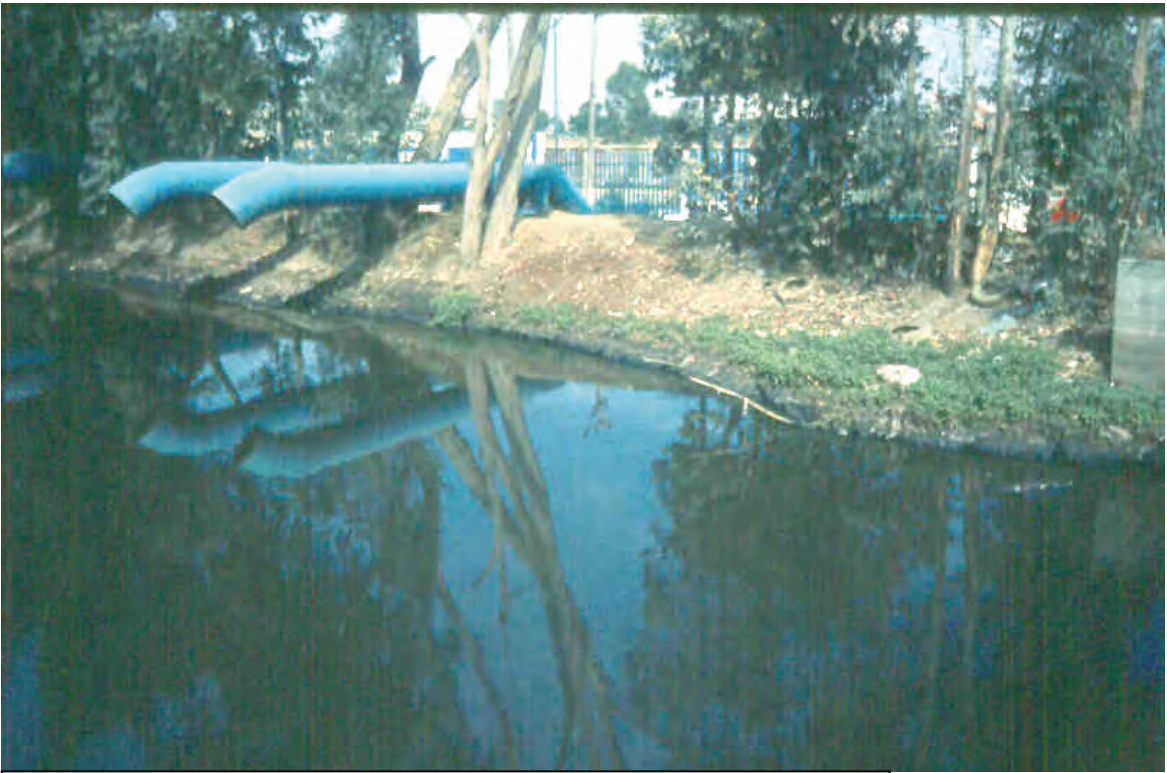
Fig. 6. Tubería de la Planta “El Hueso” que aporta agua a los canales de Xochimilco.
