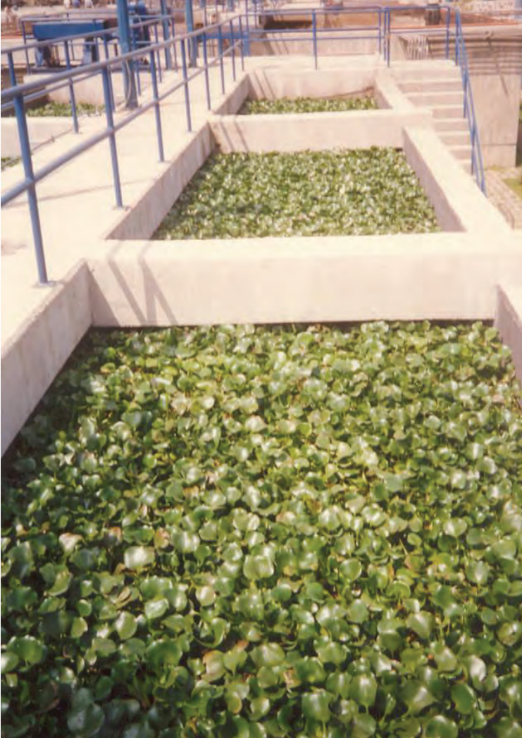
Fig. 11. Tanques con lirio acuático ( Eichhornia crassipes ) para realizar los análisis correspondientes de metales pesados.
