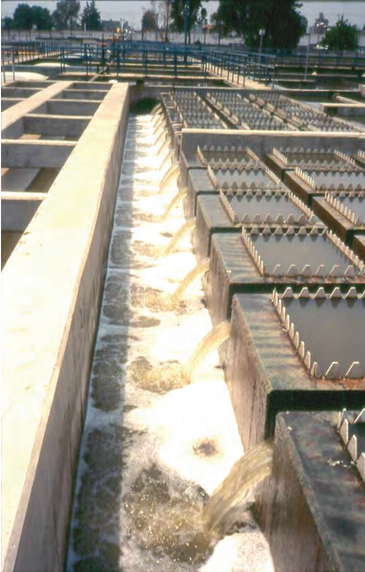
Fig. 12. Decantación del agua después de la sedimentación.
