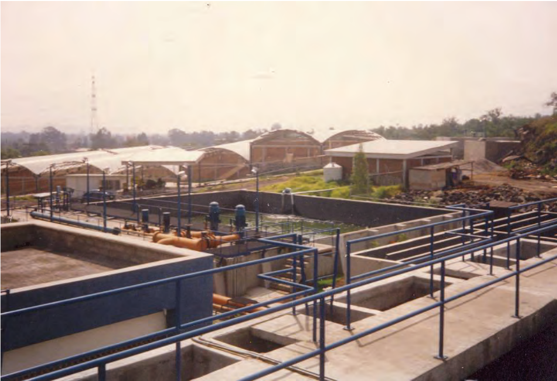
Fig. 10. Terminación del tratamiento secundario de las aguas residuales.
