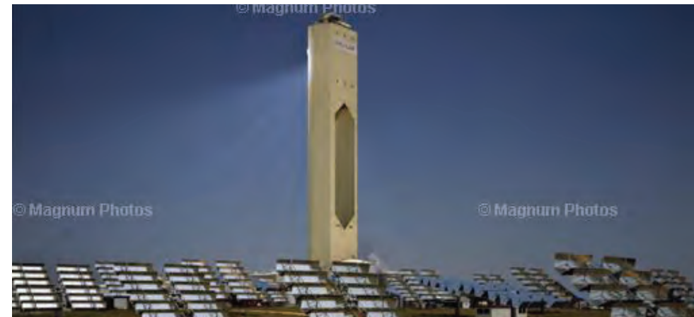
Fotografía 44. La primera planta termo-eléctrica fue realizada en España, y su funcionamiento es a través de la cración de vapor de agua al concentrar la energía solar en un punto específico a más de 700 ° C.
