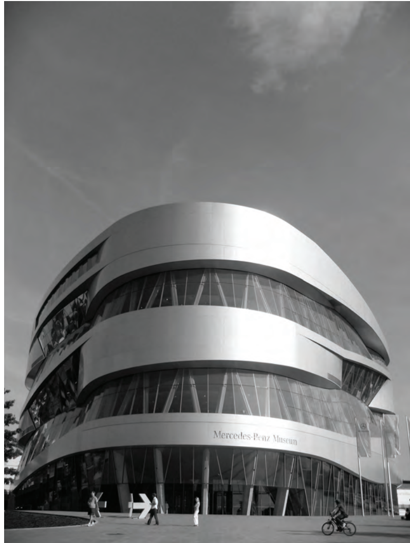
Fotografía 42. Diseñado por UN Studio, el museo de Mercedes-Benz requirió de la más sofisticada tecnología en visualización y cálculo digital para su planeación y construcción más efectiva. Cada ventana, y cada cancel son piezas diferentes que requieren de un mínimo margen de error para su colocación. Sin la tecnología digital de complejos algoritmos, éste edificio no existiría como es.
