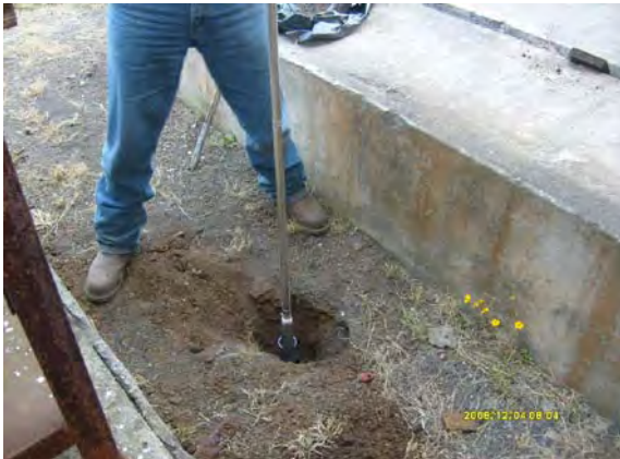
Fotografía 11. Muestreo de suelo en el sondeo SB-10
