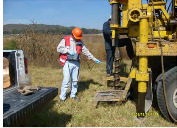
Fotografía 26. Detección de vapores orgánicos y explosividad
