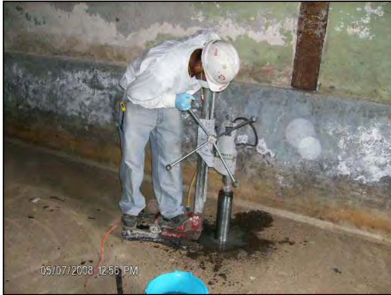
Fotografía 3. Perforación previa con nucleadora antes de la perforación manual.
