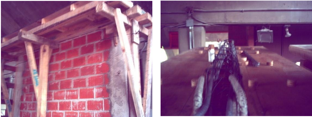
Fig. 1.28. Cimbrado de la losa y detalle de la tarima superior para anclaje.
