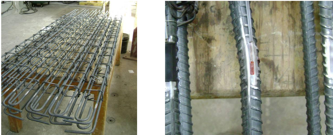
Fig. 1.30. Colocación de las galgas en las varillas de los castillos.
