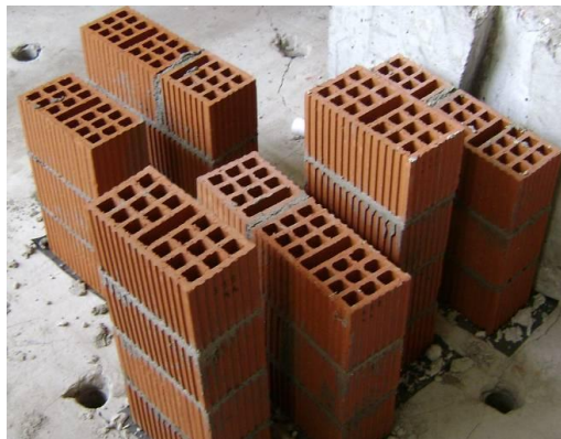
Fig. 1.6. Detalle de las pilas y muretes en el sitio de construcción.
