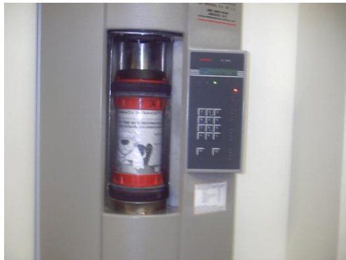
Figura 16: “Sistema Neumático.”
