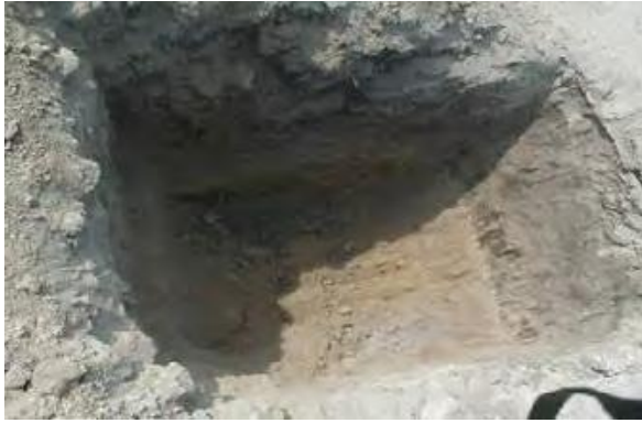
Figura 22. Pozo de absorción
