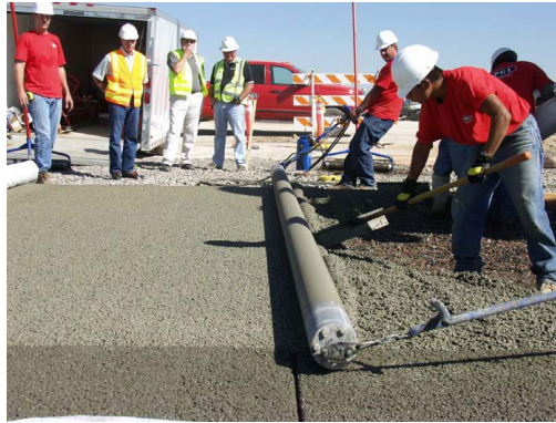
Figura 29. Compactación del concreto permeable por medio de un rodillo de acero
