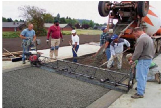
Figura 28. Enrasado del concreto permeable mediante el uso de una enrasadora vibratoria de marco con sección tipo “A”
