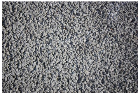
Fig. 5. Concreto permeable, donde se observa la ausencia de finos
