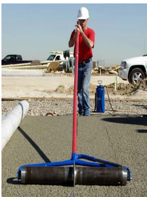
Figura 30. Realización de una junta constructiva en el concreto permeable
