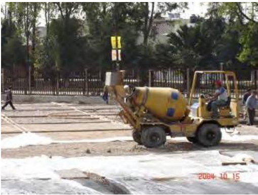
Figura 24. Uso de auto-hormigoneras para la mezcla
