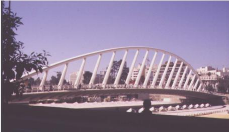
Figura 2.1 Puente « la Alameda », Valencia; arco asimétrico de acero, inclinado; Calatrava
