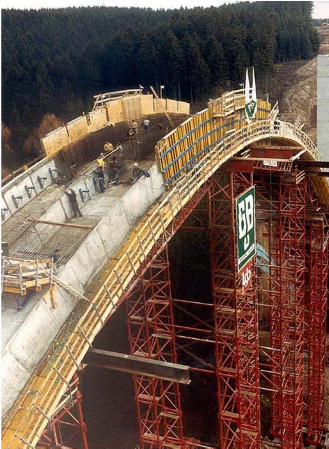
Detalle de sección en cajón del arco
