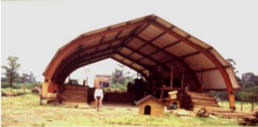
Figura 2.5: galpón con arcos triarticulados de madera laminada
