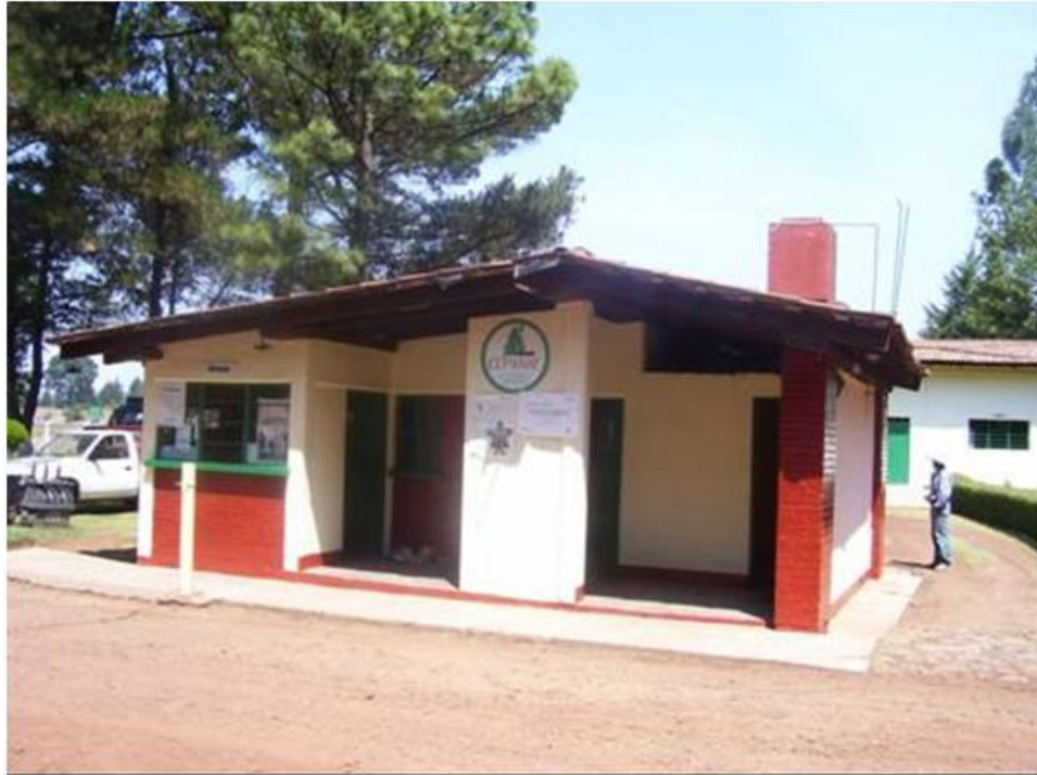
Fotografía 1. Caseta de Acceso al parque.
