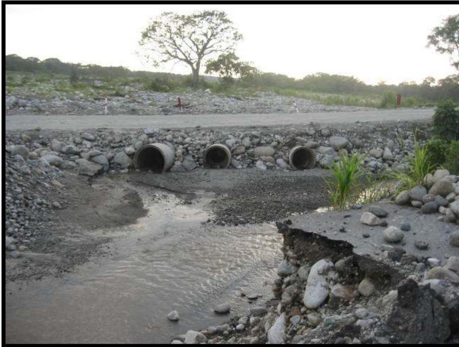
Fotografía 13. La elevación del río Cintalpa derribó el puente Cintalapa así como tramos de la carretera federal y de la autopista Arriaga-Tapachula.
