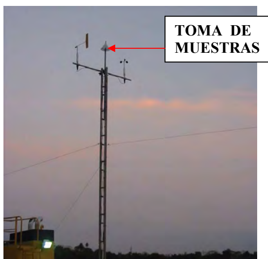
Figura 18. En esta torre se encuentra ubicada la toma de muestra (teflón).
