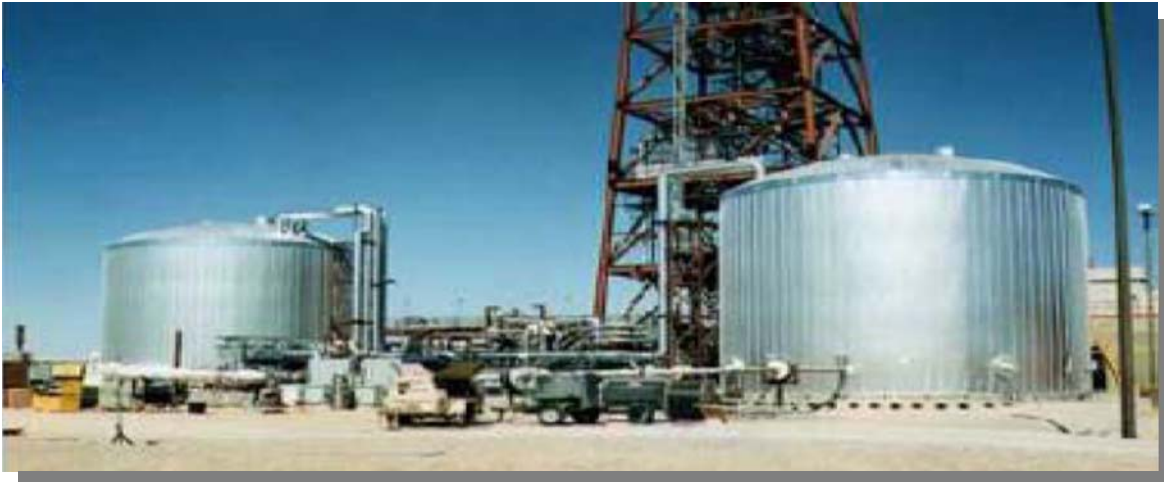
Figura No. 3.16 Sistema de almacenamiento de sales fundidas utilizado en la planta Solar Tres Fuente: Situación actual de proyectos termoeléctricos a escala mundial, ARIES Ingeniería y Sistemas, 2008.
