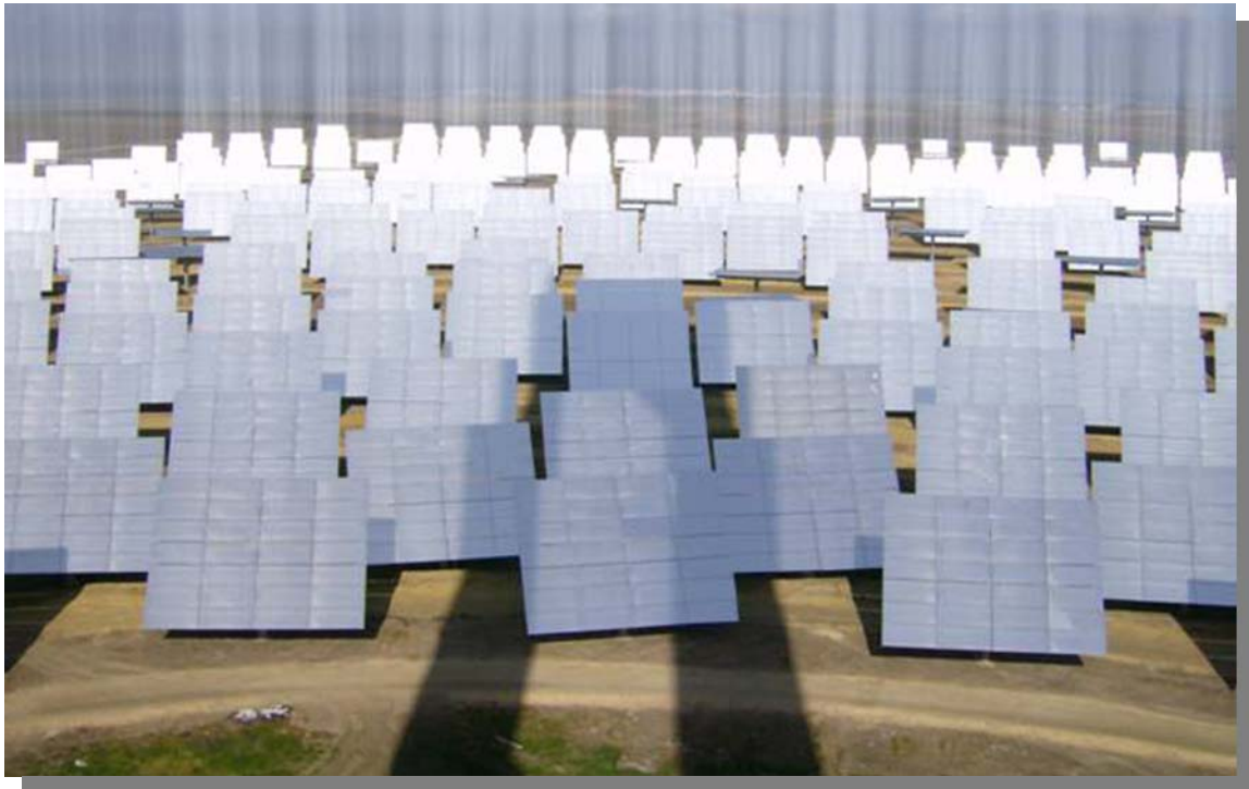
Figura No. 3.10 624 Helióstatos Sanlúcar de 120m 2 C/U reflejan los rayos del Sol hacia la torre de la PS10. Fuente: ABENGOA SOLAR , http://www.abengoasolar.es , 2009.
