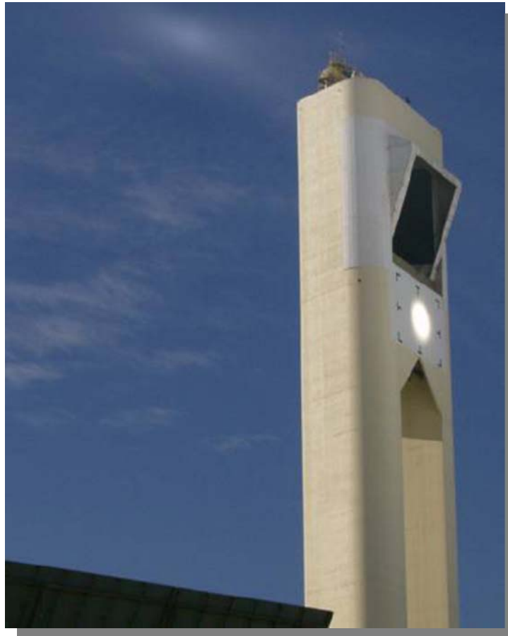
Figura No. 3.13 El receptor de la PS10 es de tipo de cavidad. Fuente: Abengoa Solar , http://www.abengoasolar.com/ , 2009.
