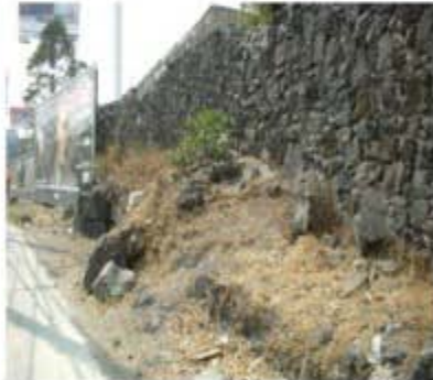
14. MURO DE PIEDRA
