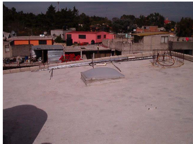
Figura 4. Pendiente en área de captación
