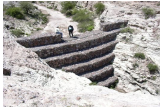
Figura 1. Presa tipo gavión
