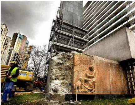
MONUMENTO DE JOSE ANTONIO PRIMO DE RIVERA EN LA CIUDAD DE BARCELONA, DEMOLIDO PARA DAR PASO A LA CONSTRUCCIÓN DE LA “NUEVA” CIUDAD
