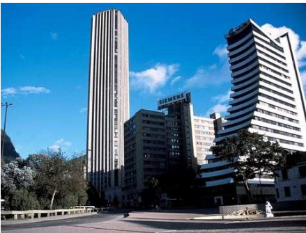
TORRE COLPATRIA. EL EDIFICIO MÁS ALTO DE BOGOTÁ. UPZ SAN MARTIN, CENTRO DE BOGOTÁ
