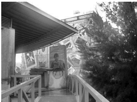
Acceso Biblioteca por Rampa Posterior
