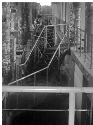
Pasillo Principal desde Planta Alta
