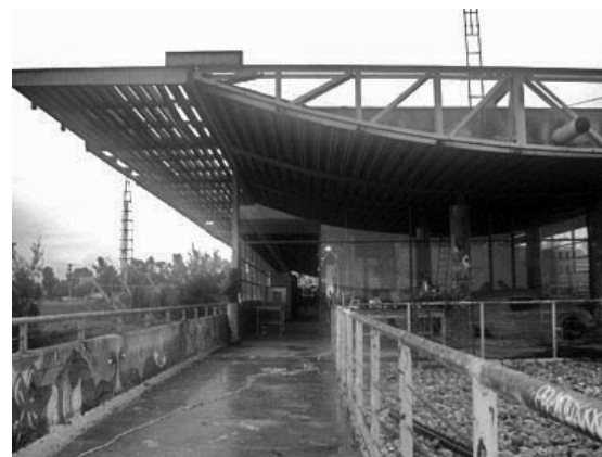
Acceso Planta Alta Nave Principal por Galería
