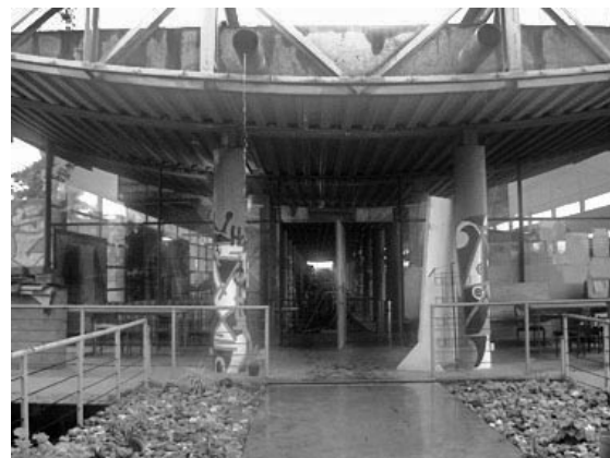
Acceso Nave Principal por Biblioteca
