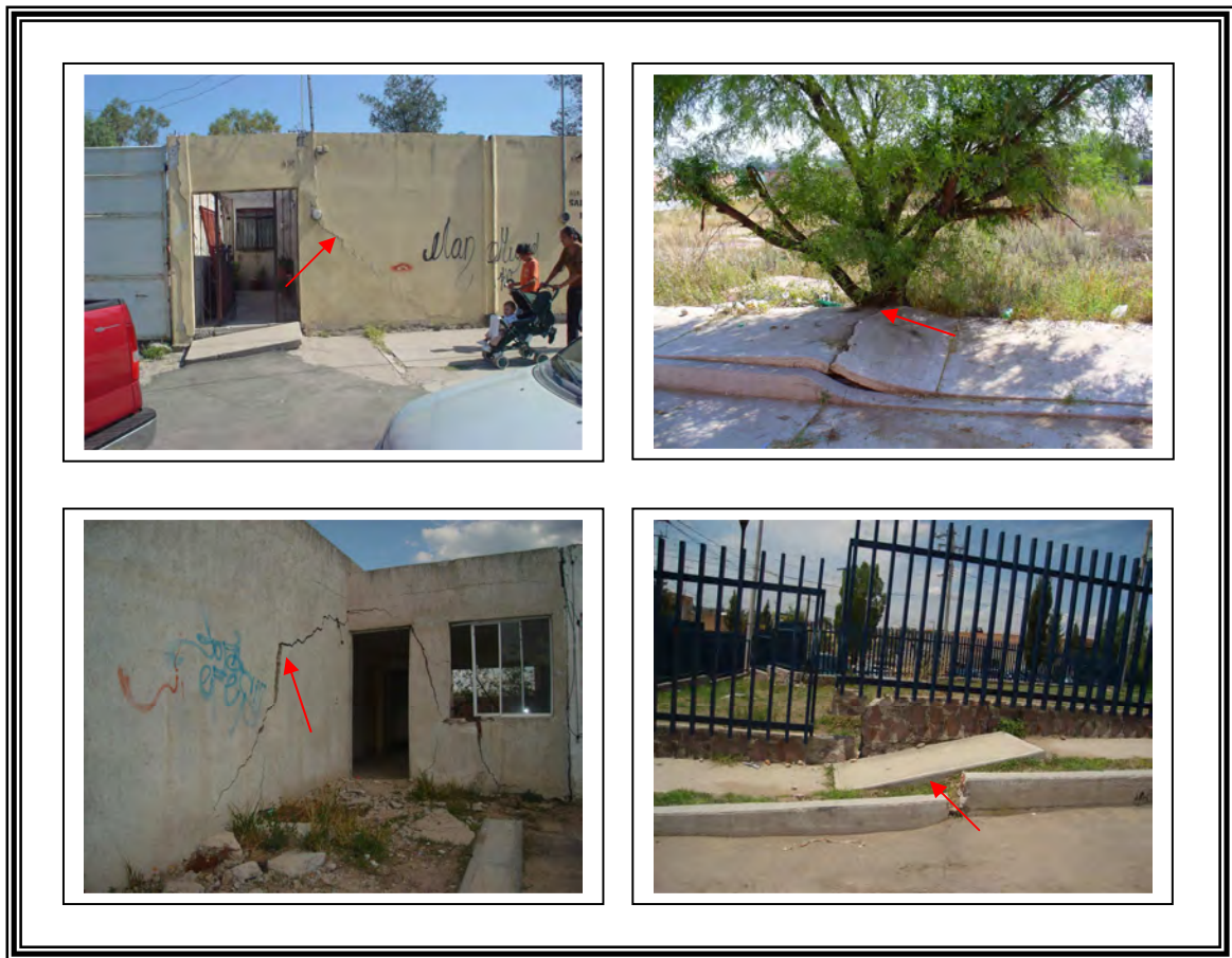
Figura 1.2. Ejemplos, casas y edificios afectados por el agrietamiento en el subsuelo, las flechas rojas indican las zonas de afectación por las fallas.
