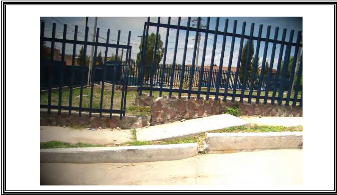
Figura 6.9. Centro de Salud Comunitario del Fraccionamiento del Valle
