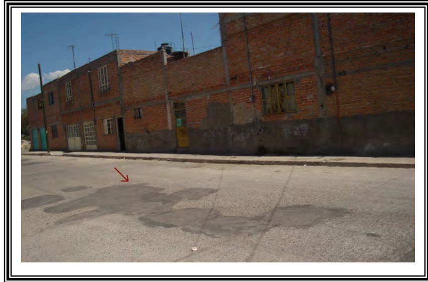
Figura 6.3. Calle Adolfo López Mateos, la flecha roja indica la zona de afectación en la calle, que ha sido reparada con un nuevo pavimento
