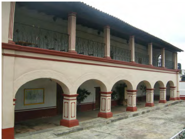
Arquería del convento en el flanco sur (fotografía: Jorge J. Bobadilla)
