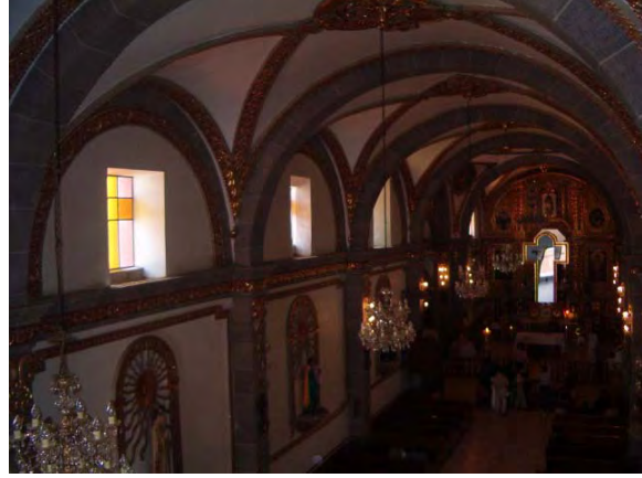
Bóveda de cañón con lunetos (fotografía: Jorge J. Bobadilla)
