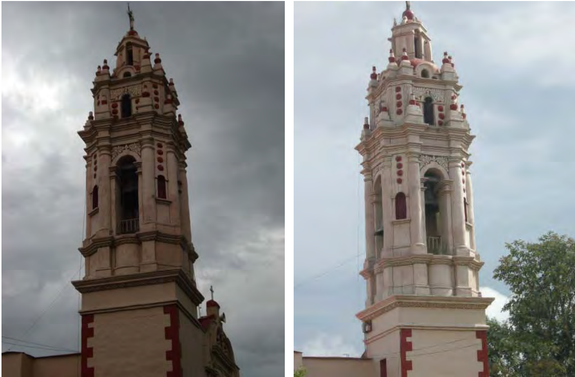
Campanario lado norte (fotografía: Jorge J. Bobadilla)
