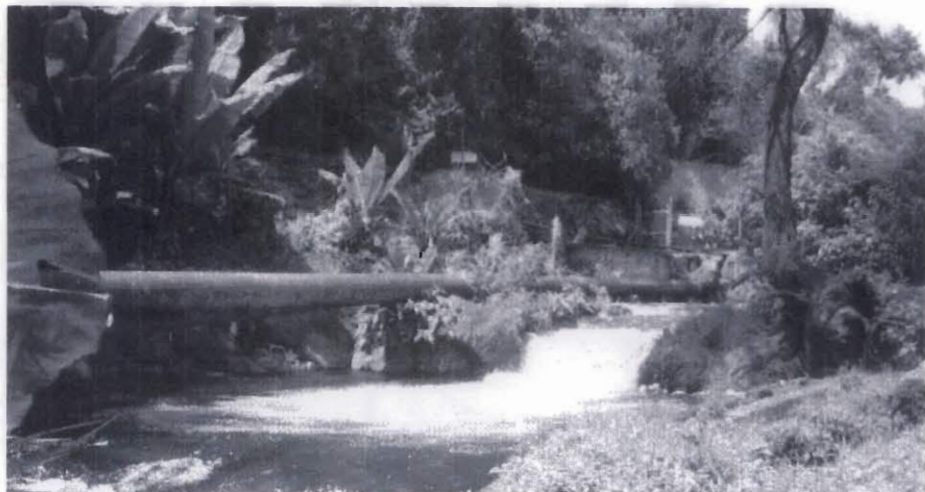
Colector de agua potable Gandarillas II
