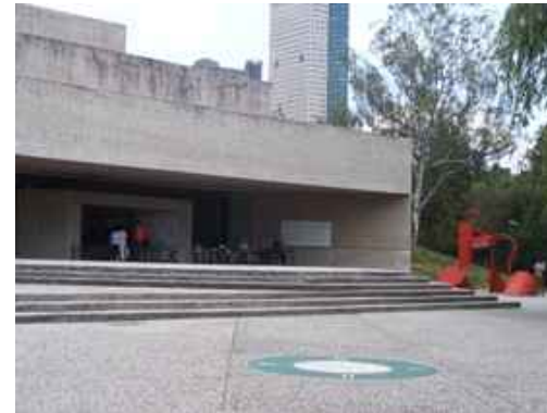
Fig. 4.15 Vista general del acceso. Aquí se puede apreciar que cuenta con una amplia plaza
