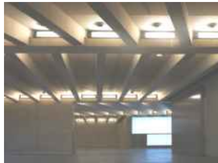
Fig. 4.1 Techo conformado por vigas prefabricadas de hormigón blanco
