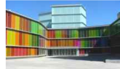
Fig. 4.5 Plaza pública de 1,500 m 2 , de forma cóncava
