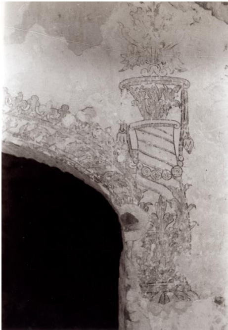
FOTO 3.- Claustro. Jalapa del Marqués, Oax.
