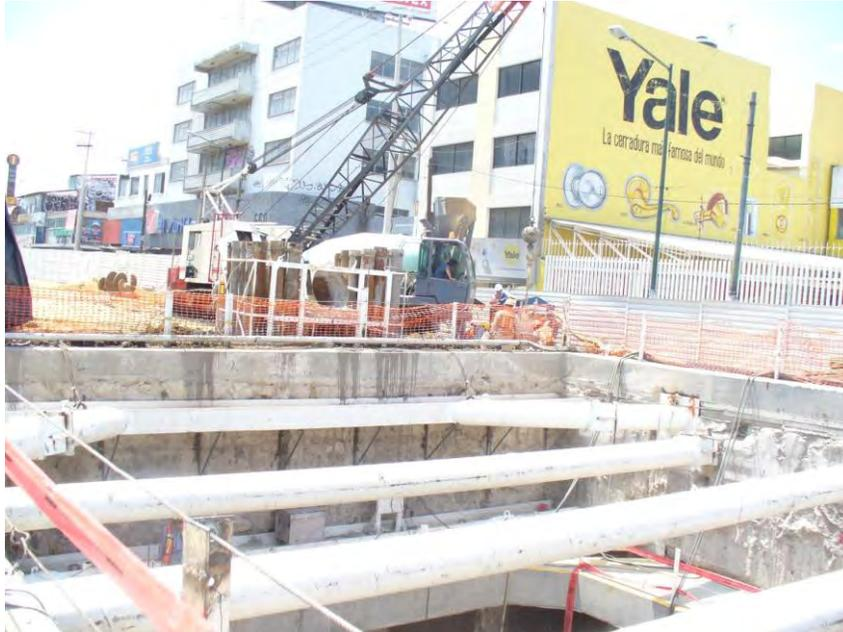
Troqueles deteniendo al muro Milán mientras se efectúan los trabajos de relleno y compactado (Imagen: I-XIII)
