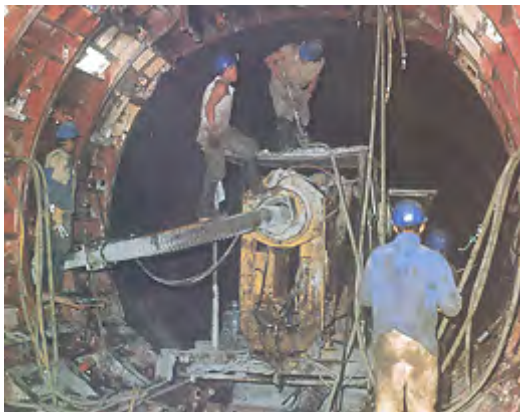
FIGURA 3.2.2. CONSTRUCCIÓN DE EMISORES DE DRENAJE.
