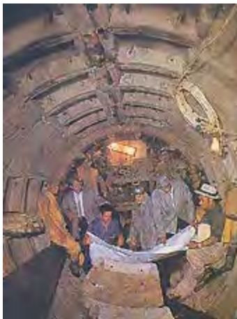
FIGURA 3.2.3. REVISIÓN DE ESTRUCTURAS DE DRENAJE
