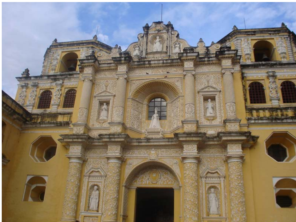
Figura. XXVII. Fotografía actual del Templo de la Merced, ubicado en la primera calle Poniente en la actual ciudad de Antigua, Guatemala. El templo funge como el principal edificio religioso mientras concluyen los trabajos de restauración de la Catedral. Por su magnificencia, estilo y belleza han considerado nombrarlo Patrimonio de la Humanidad.
