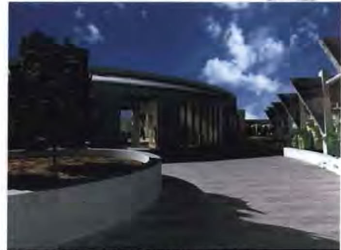
Acceso al Edificio de administración general
