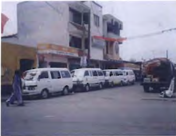
Foto No. 9 La base de transporte público, carece de señalización horizontal y/o vertical, que contenga la identificación de la ruta.
