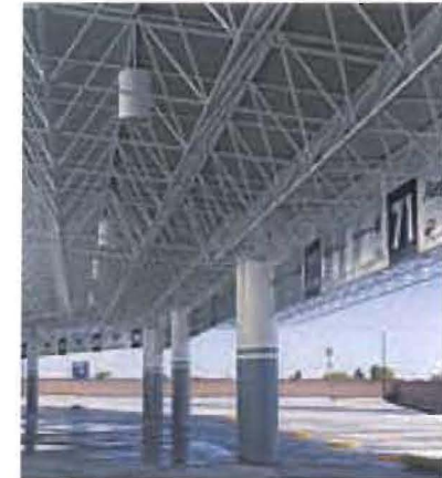
Fotografía No.4 Estructura tridimensional, para lograr claros más grandes
