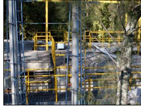
Figura 5.6 Tanque de aireación
