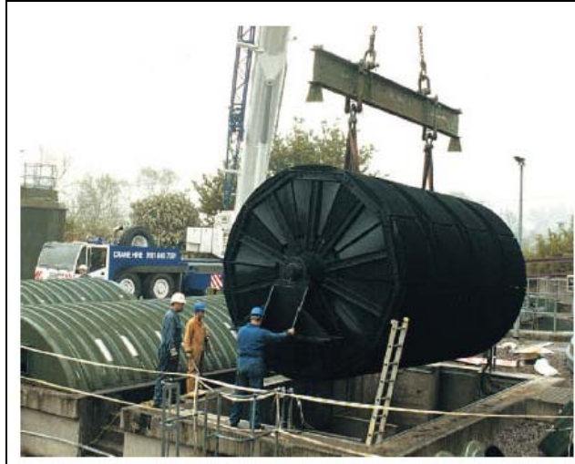
Figura 2.7 Foto de un reactor biológico rotativo de contacto (Carballa y col., 2004)
