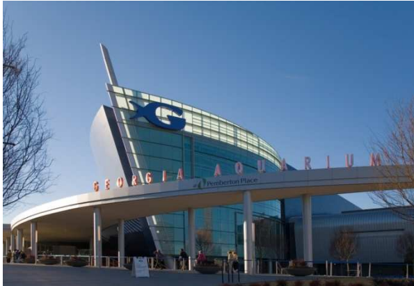
FACHADA DE ACCESO
