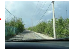
ACCESO AL TERRENO
