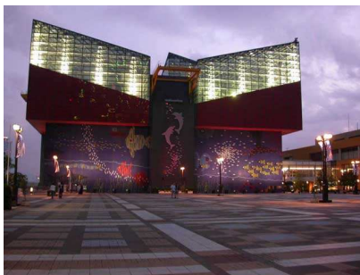
FACHADA DE ACCESO
