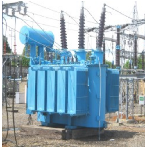
Figura 2.37 Transformador de distribución tipo subestación.
