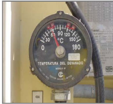
Figura 2.39. Indicador de temperatura de devanados.
