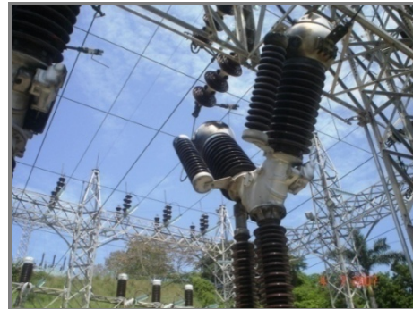
Figura 2.43. Interruptor en pequeño volumen de aceite.
