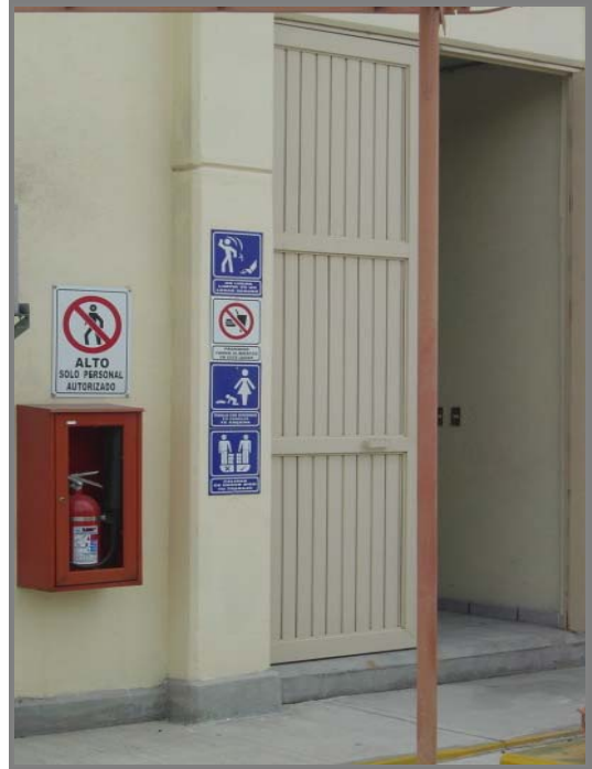
Figura 2.101 Extinguidor en área de la subestación.
