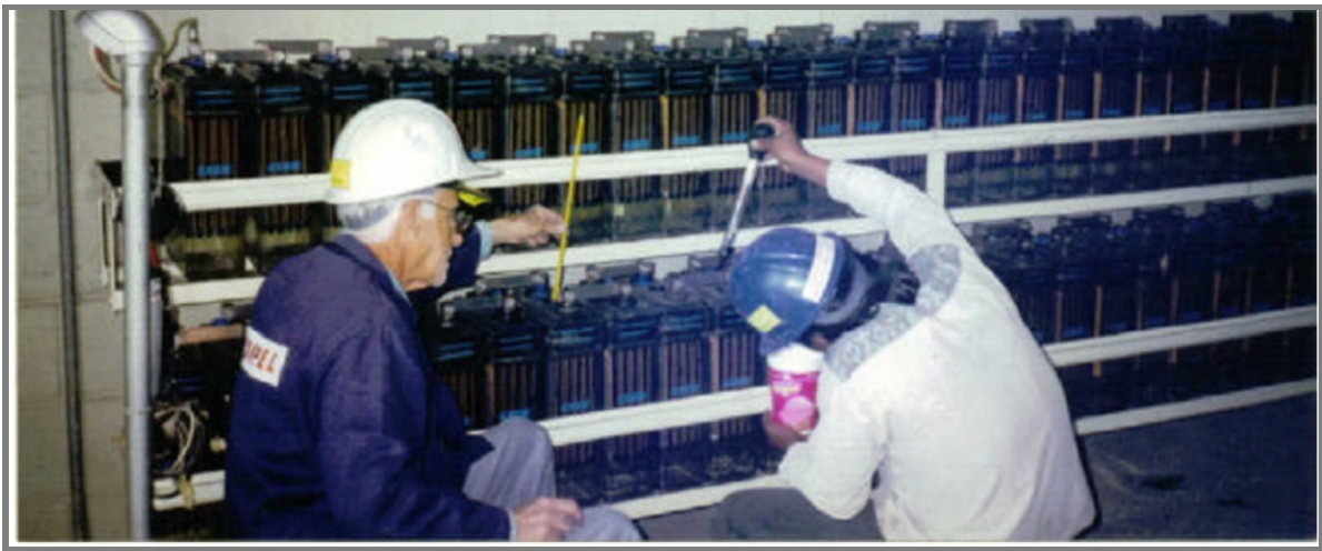
Figura 2.92. Revisión de los electrolitos en el banco de baterías.
