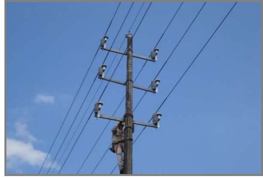
Figura 2.82. Apartarrayos tipo distribución tipo ALEA.
