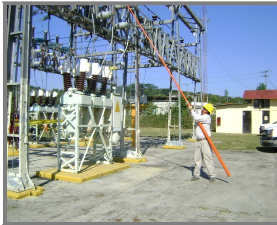
Figura 2.75. Cuchillas desconectoras solidas monopolares.
