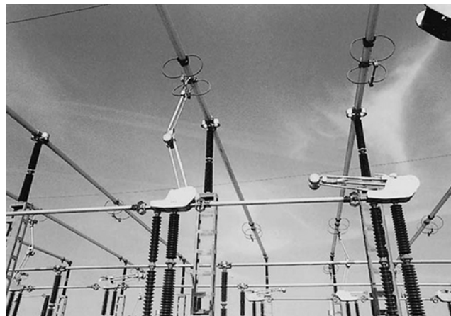
Figura 2.70. Cuchillas desconectadora tipo pantografo.
