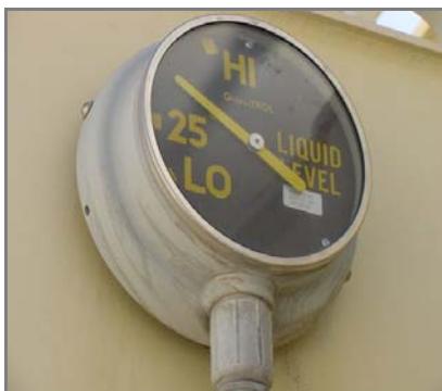
Figura 2.38. Indicador de nivel de aceite.
