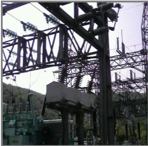
Figura 2.90. Transformadores de potencial en el bus de 34.5kv. Figura 2.91. Transformadores de corriente a la llegada de la subestación.
