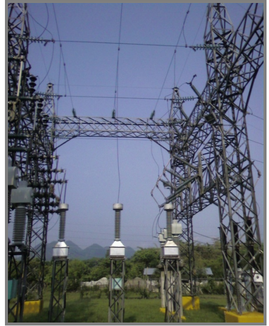
Figura 2.88. Transformadores de potencial a la llegada de la subestación. Figura 2.89. Transformadores de potencial en el bus principal de 115kv.
