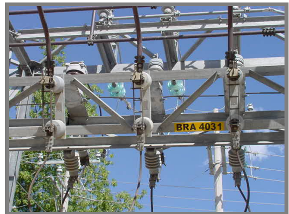
Figuras 2.68 Cuchillas secas monopolares.
