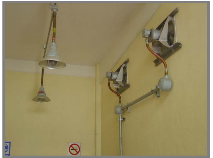
Figura 2.94. Equipo de aire acondicionado y toma de agua con lavabo. Figura 2.95 Alumbrado a prueba de explosión y ventilación constante.
