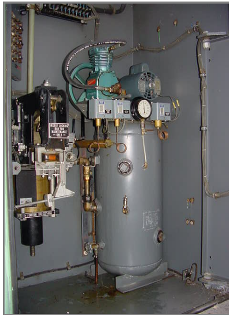
Figura 2.52. Sistema neumático de interruptor de gran volumen de aceite.
