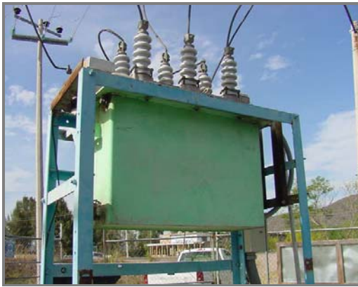
Figura 2.54 Restaurador electromecánico.
