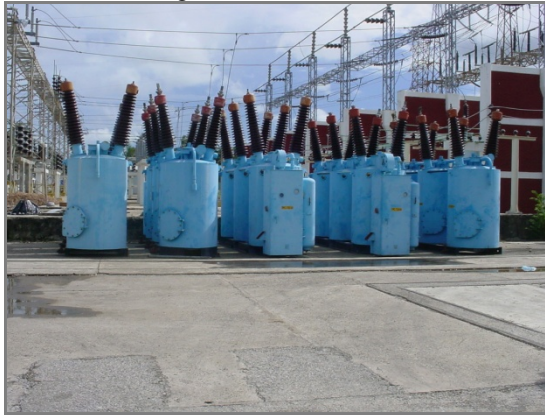
Figura 2.41. Interruptor gran volumen de aceite monofásico.
