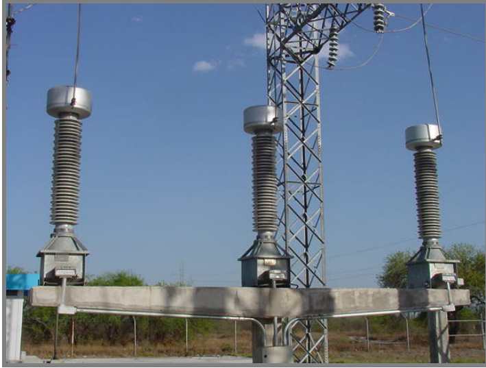
Figura 2.88. Transformadores de potencial a la llegada de la subestación. Figura 2.89. Transformadores de potencial en el bus principal de 115kv.
