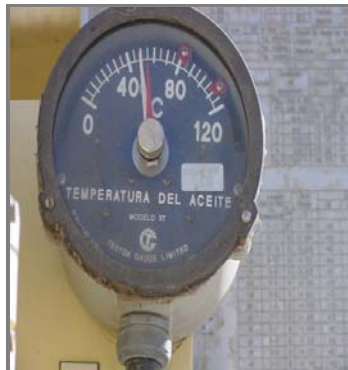
Figura 2.40. Indicador de temperatura de aceite.
