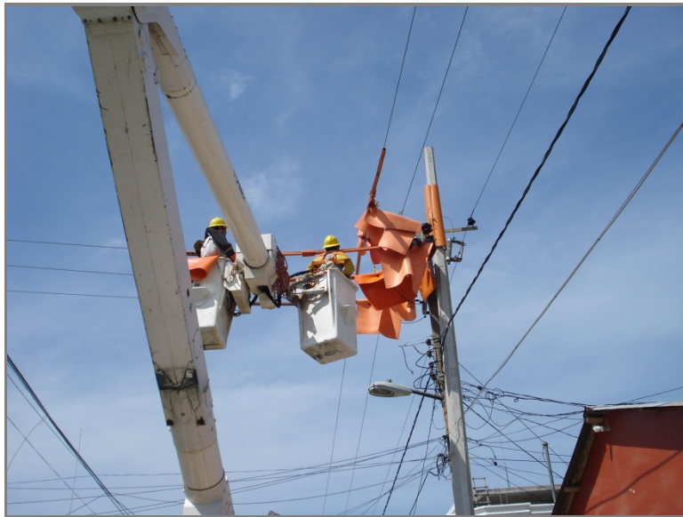
Figura 4.36. Trabajos en línea energizada utilizando mantas.
