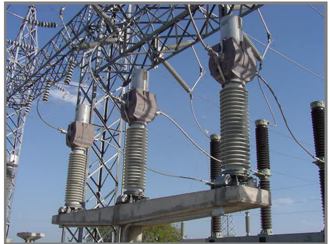
Figura 2.90. Transformadores de potencial en el bus de 34.5kv. Figura 2.91. Transformadores de corriente a la llegada de la subestación.
