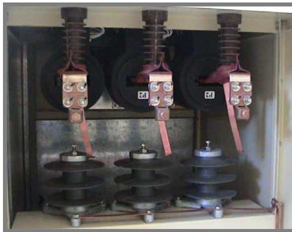
Figura 2. 79. Apartarrayo tipo ALEA integrado en interruptor.
