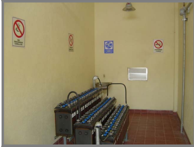
Figura 2.94. Equipo de aire acondicionado y toma de agua con lavabo. Figura 2.95 Alumbrado a prueba de explosión y ventilación constante.
