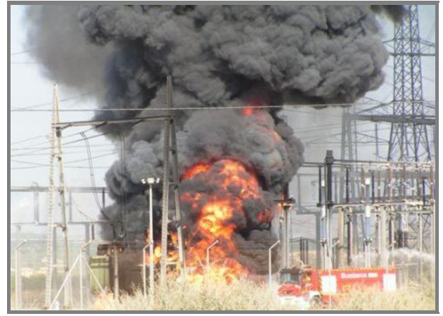
Figura 2.104 Incendio ocasionado por falla de aislamiento en conexiones subterranas en una trinchera.
