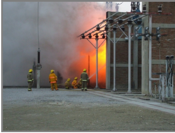
Figura 2.104 Incendio ocasionado por falla de aislamiento en conexiones subterranas en una trinchera.
