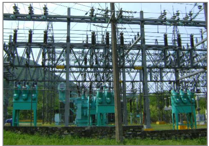
Figura 2.49. Interruptor al vacío, con aislamiento en SF 6 .
