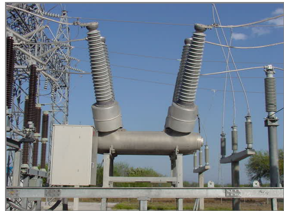
Figura 2.46. Interruptor en SF 6 en tanque en muerto.
