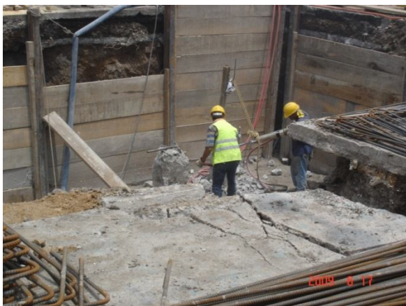
Excavación, colado de plantilla y descabece de pilotes.
