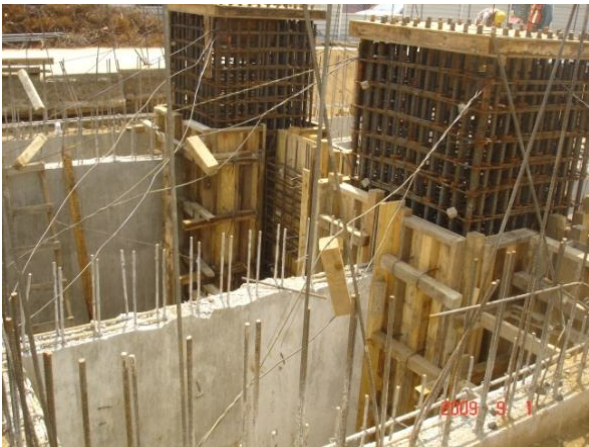
Armado y colado de muros perimetrales y contrarabes.
