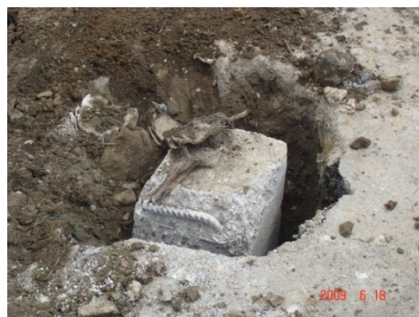
Hincado de los pilotes de fricción.
