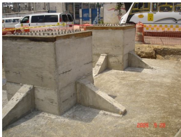
Armado y colado de losa tapa y bases para columnas.
