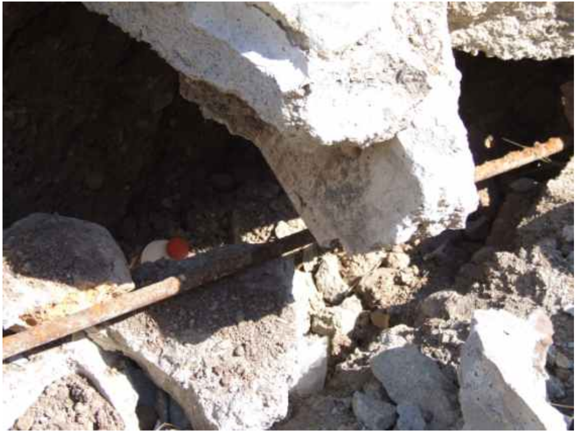
Fig. 9.2.3 Tubo de agua reparado
