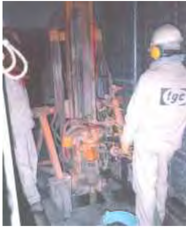
Fig. 6.1.29 Perforación desde el nivel de criptas para la instalación de tubo de manguitos
