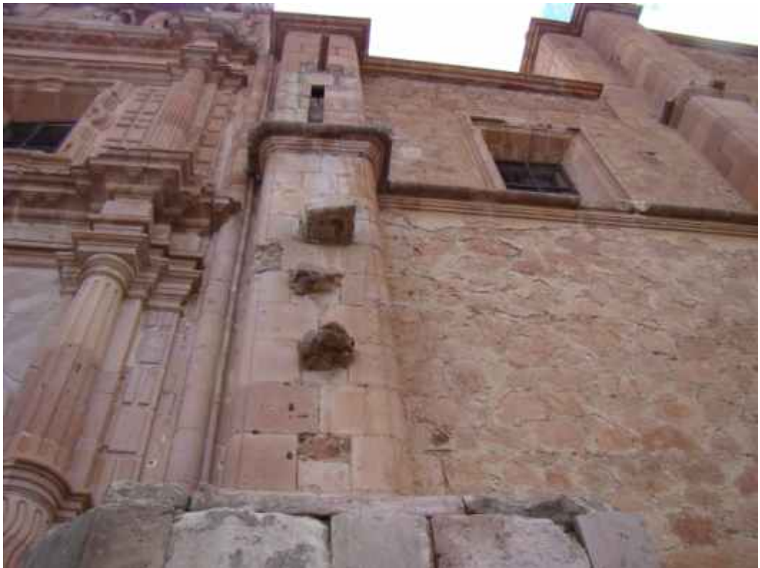
b) Piedras de unión para un posible contrafuerte
