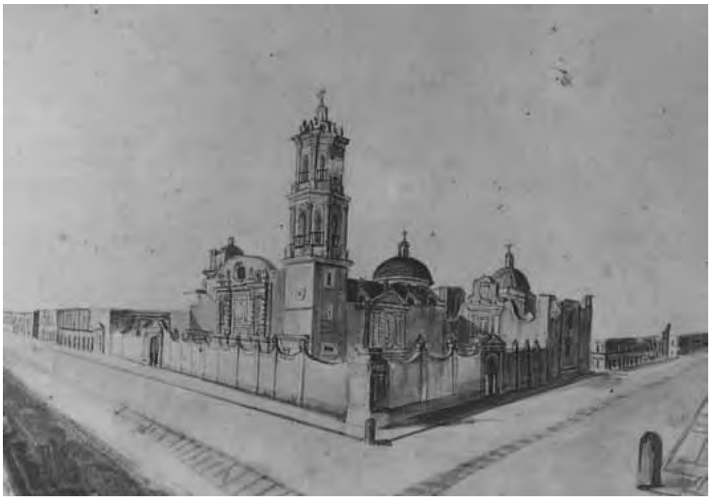
Fig. 6.3.1 Exterior de San Agustín según una acuarela de 1853. Aquí apreciamos el conjunto exterior de este magnífico edificio cuando aún existía la barda atrial y la iglesia ostentaba sus dos torres. Se aprecian las tres portadas: La principal, adornada con un magnífico relieve que representaba a San Agustín; la del costado, con un relieve de la Virgen de Guadalupe y la de la capilla del Tercer Orden, todas modificadas por Vicente de Heredia, quien transformó el conjunto (Tovar de Teresa, 1991)
