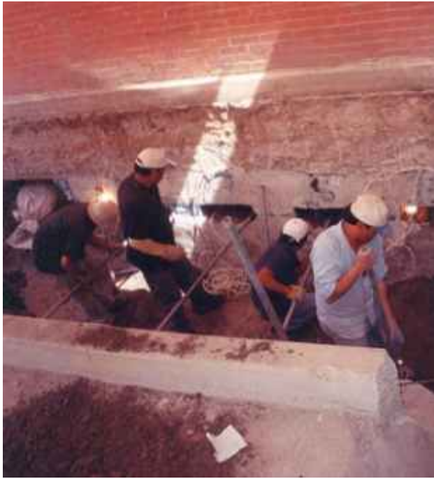
Fig. E.14 Subexcavación manual
