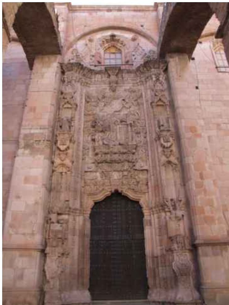
Fig. 10.1.6 Contrafuertes en la fachada norte
