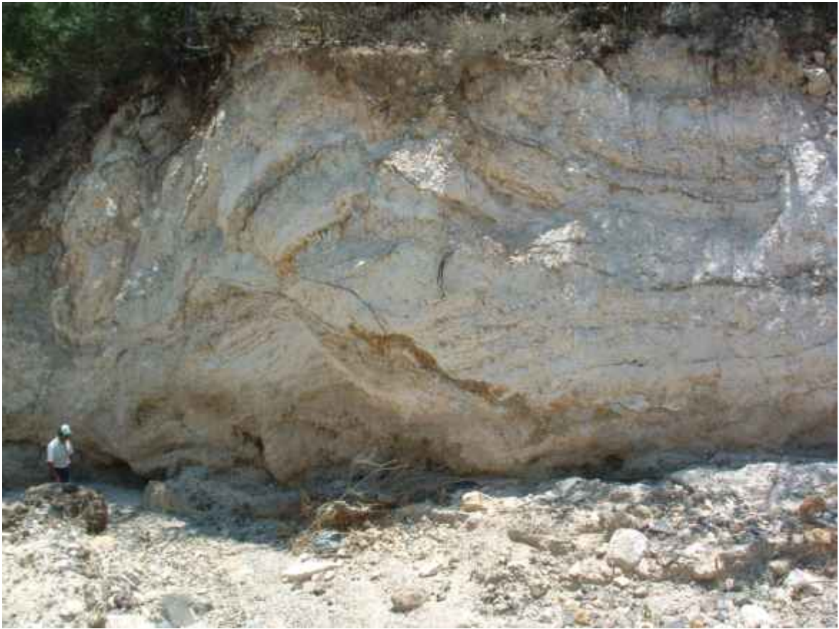
Fig. 9.1.3 Talud derecho del arroyo Tlaxomoti, observese su inestabilidad
