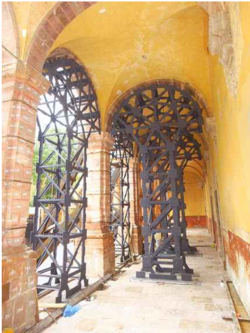
Fig. 14.1.17 Estructura de apuntalamiento temporal
