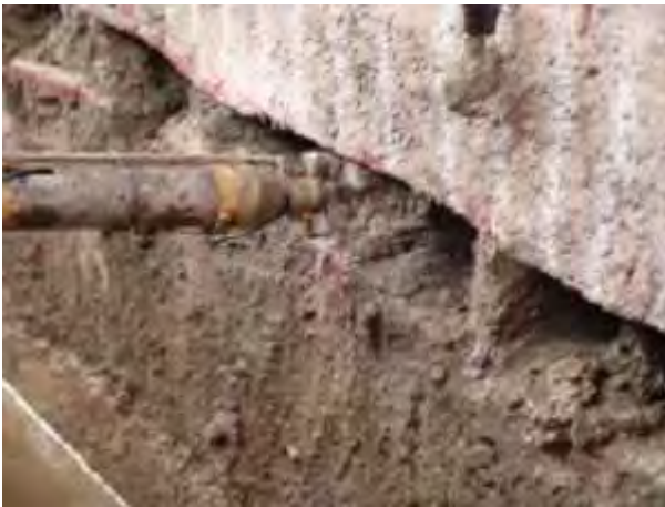
Fig. E.16 Subexcavación con helicoides
