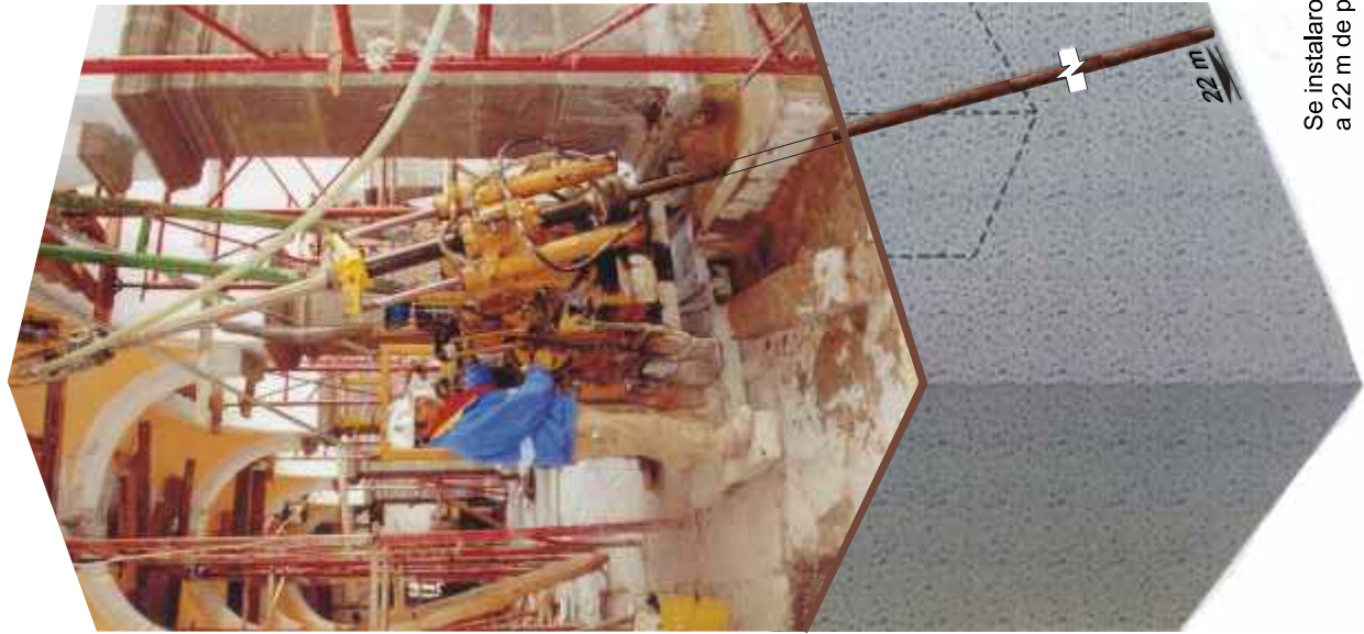
Fig. 11.2.10 Recimentación de la esquina suroriental del Edificio Carolino BUAP
