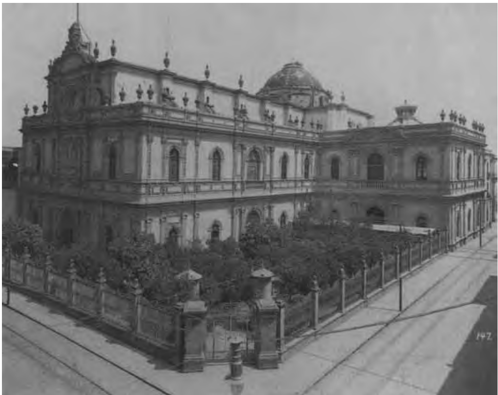
Fig. 6.3.2 Vista de San Agustín, consumada su transformación exterior. En esta fotografía observamos la transformación de la vieja iglesia en biblioteca. Se salvaron las columnas salomónicas y el relieve de la portada principal; el tablero de la portada lateral desapareció. La portada de la capilla del Tercer Orden se conservó en su estado original, hasta que fue finalmente ocultada con otra fachada, que se hizo con objeto de darle uniformidad al nuevo aspecto exterior. (Tovar de Teresa, 1991)
