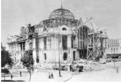
Fotografía tomada en agosto de 1910, cuando se inició la inyección del subsuelo.
