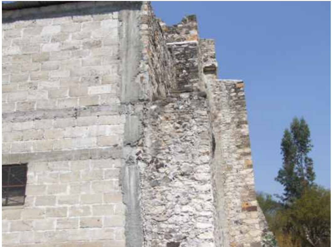
Fig. 9.2.8 Estructura adherida con elementos de concreto
