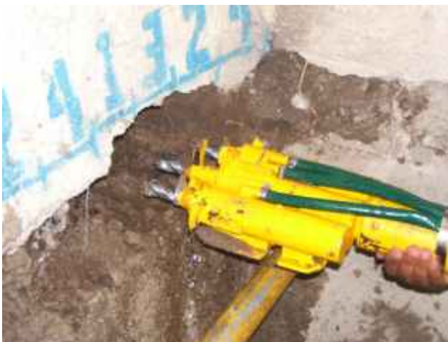
Fig. E.18 Perforación con hidrotopo
