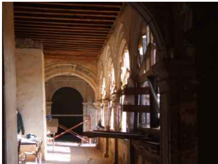
Fig. 7.1.5 Apuntalamiento del claustro
