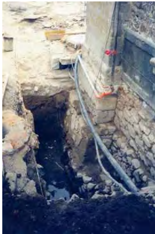
Fig. 6.7.5 Vista de la cimentación en la esquina nor-oeste de la nave
