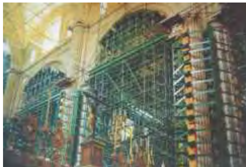
Fig. 6.1.24 Estructura tubular de seguridad de los arcos así como el entablillamiento de dos columnas..
