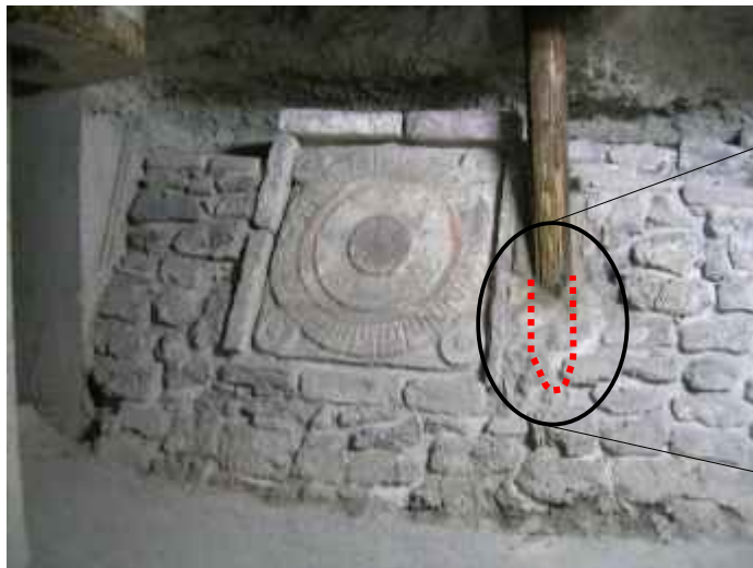
Fig. 4.6 Pilotes en el Sagrario anexo a la Catedral de México
