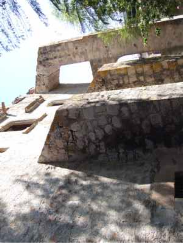
Fig. 7.2.4 Atrio botarel y contrafuertes
