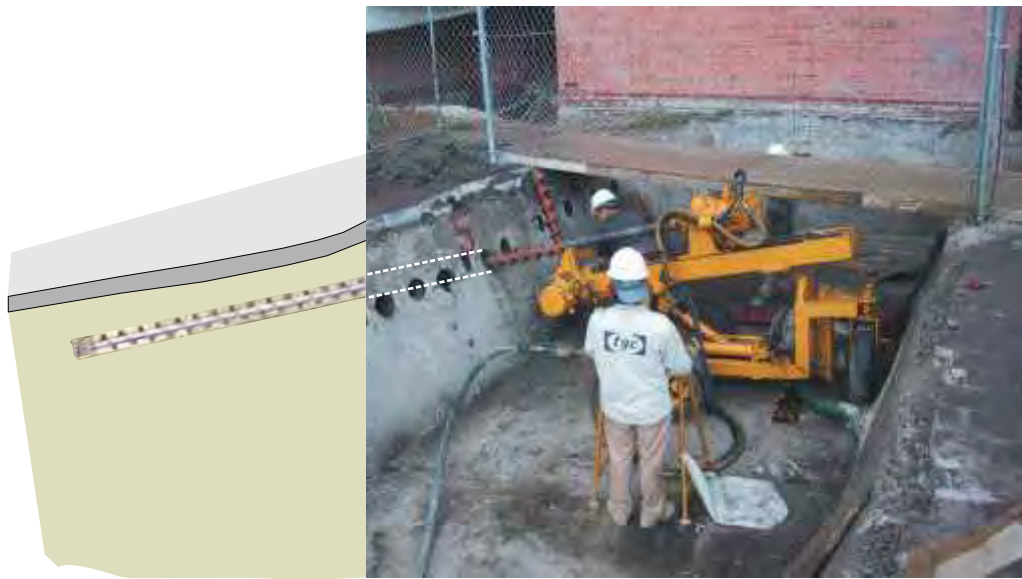
Fig. E.16 Subexcavación con helicoides
