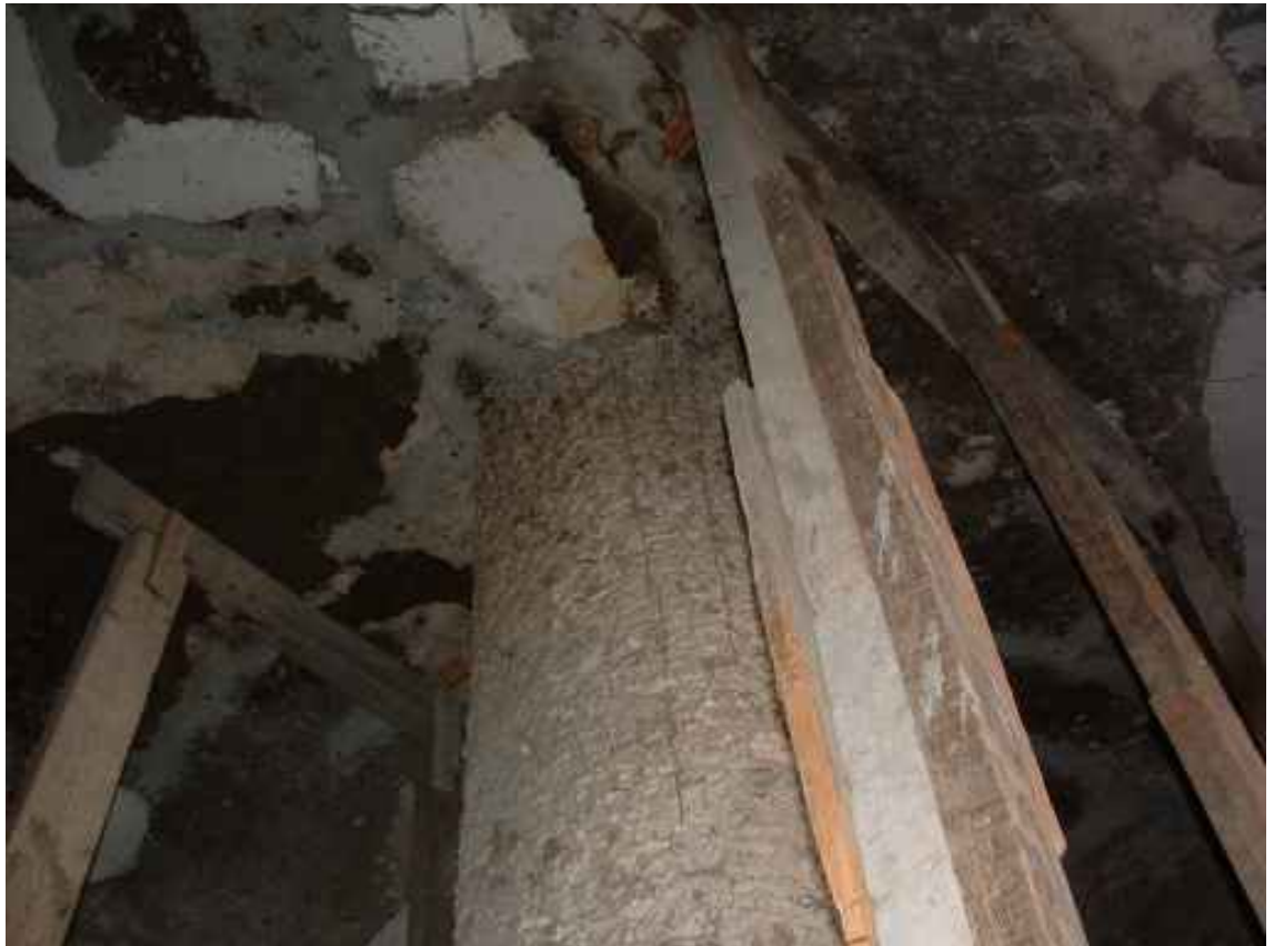
Fig. 9.1.14 Apuntalamiento en una de las bodegas
