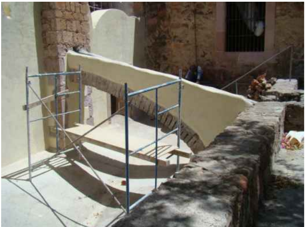
b) Arco botarel en el eje 2 del Generalito
