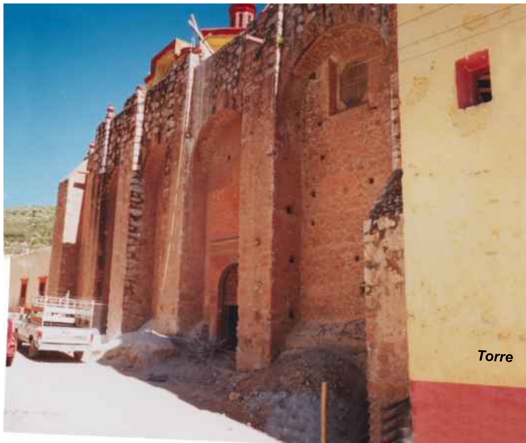
Fig. 13.1.3 Contrafuertes de la fachada poniente
