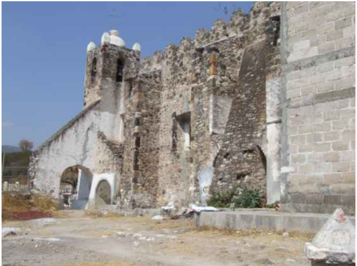
Fig. 9.2.7 Muro y arco botarel del lado sur
