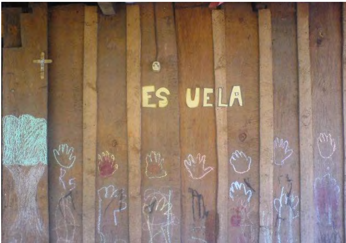
Escuela Primaria CONAFE Las manos de la alegría, (el muro de los sueños
