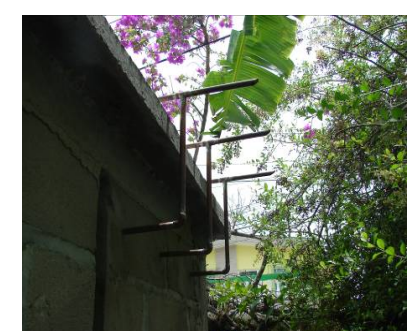
FOTO III.10. SISTEMA DE EYECCIÓN MURO ORIENTE.
