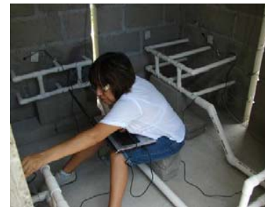
FOTO III. 13. TRABAJO DE CAMPO. El registro de los datos se programó para cada hora y es necesario trabajar in situ para descargar los datos en la PC en los intervalos en que no hay programado registro para evitar discontinuidad.
