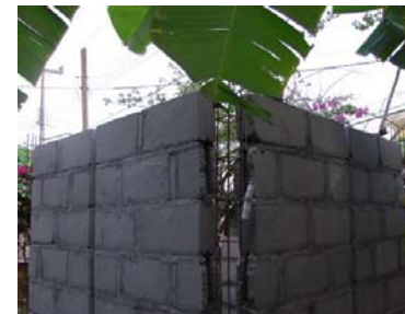
FOTO III. 1. CONSTRUCCIÓN DE LOS MUROS.
