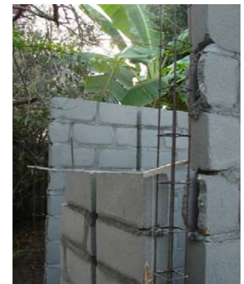
FOTO III. 2. MURO NORTE DEL SISTEMA ARQUITECTÓNICO.
