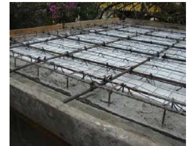
FOTO III. 4. CONSTRUCCION DE LA LOSA.
