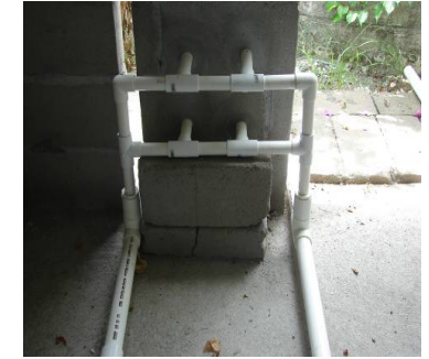
FOTO III.8. SISTEMA INYECTOR MURO NORTE. El muro norte, por sus dimensiones, tuvo menor número de boquillas inyectoras.
