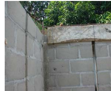
FOTO III. 3. INTERIOR NOR-PONIENTE DEL SISTEMA ARQUITECTÓNICO.
