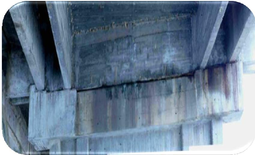
Fig. 62 Detalle de cabezal en pila 3 con manchas de humedad.
