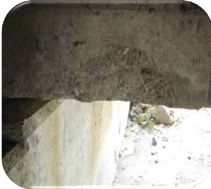
Fig. 91 Se observan manchas de humedad con desprendimiento de material en cabezal.
