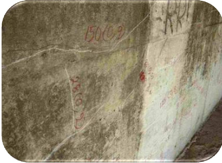
Fig. 39 El cabezal tenía varias fisuras sin un patrón definido de longitudes y espesores variables.
