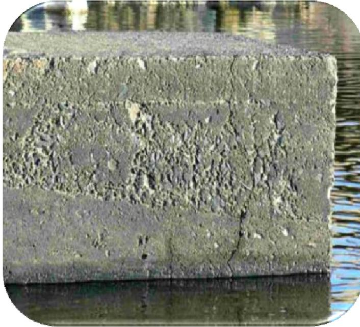
Fig.71 Detalle de fisuras y oquedad en la zapata.
