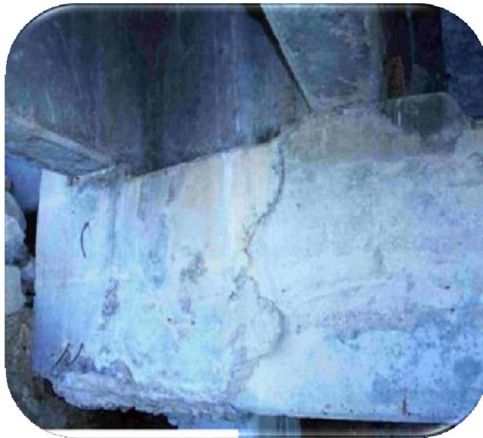
Fig. 48 En el cabezal se pueden apreciar las fisuras, la humedad y el desconche de material.
