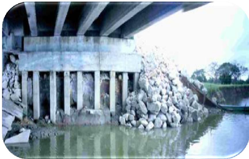
Fig.42 Se observa socavación y manchas de humedad en el cabezal del caballete 6
