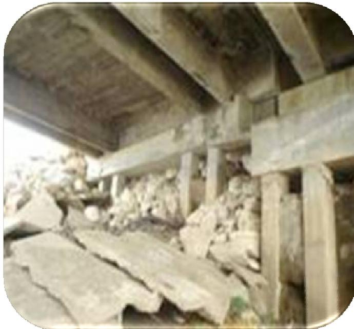
Fig.46 Caballete 6 presenta humedad, desconche de material y fisuras.
