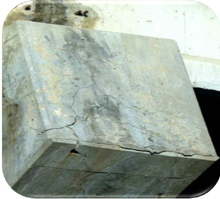
Fig. 67 Detalle de manchas de humedad en el cabezal donde se observan fisuras de distintas longitudes en cuerpo "B".
