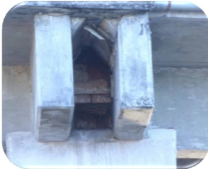
Fig. 66 Detalle de la junta de dilatación en cuerpo "A" donde se observan manchas de humedad y desconche de material.
