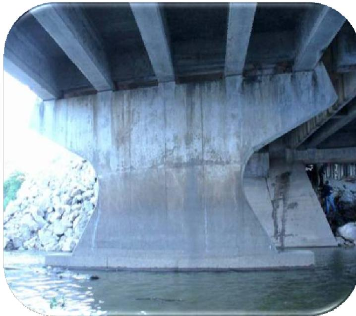
Fig. 58 Vista de pila eje 2 cuerpos "B" donde se observan manchas de humedad
