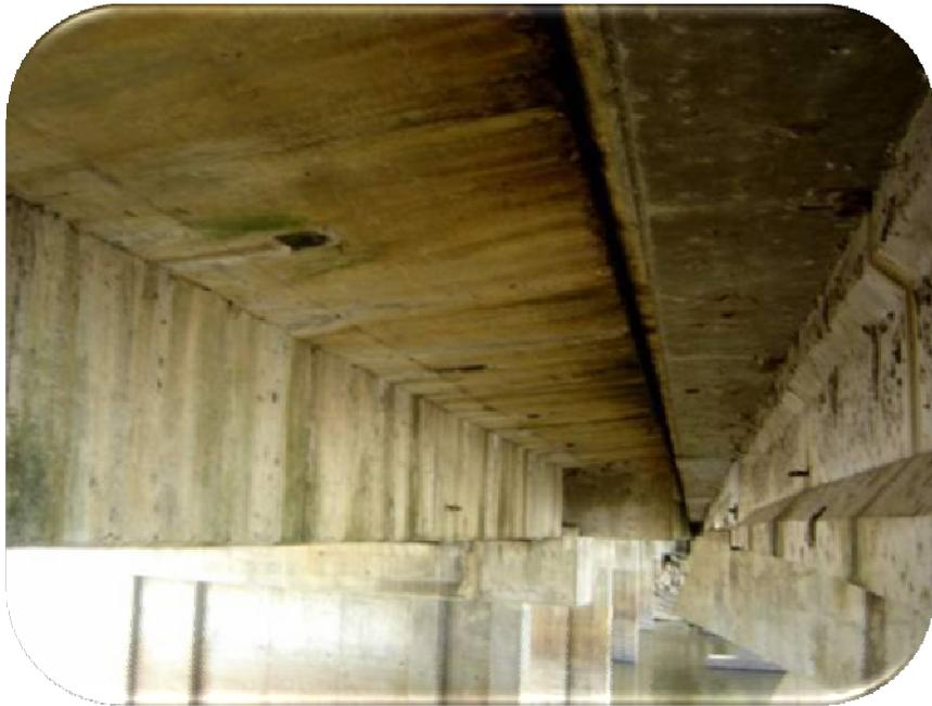
Fig.74 Se puede observar muchas manchas de humedad y fisuras
