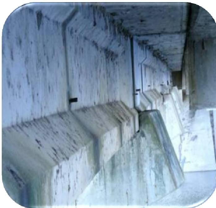
Fig.89 Se aprecian manchas de humedad
