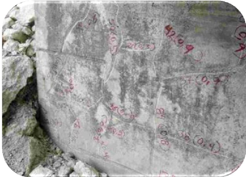
Fig. 38 Se muestra el extremo derecho y la parte frontal del cabezal donde se tienen fisuras.
