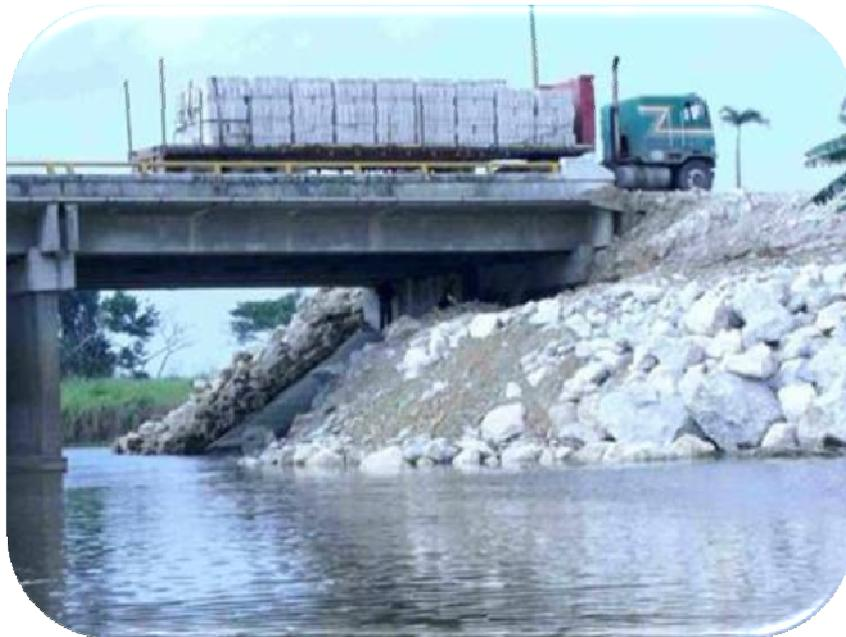
Fig. 52 Vista de estribo donde se aprecia la socavación
