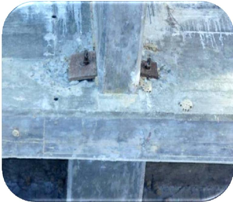
Fig. 82 Detalle del diafragma expuesto a la corrosión.
