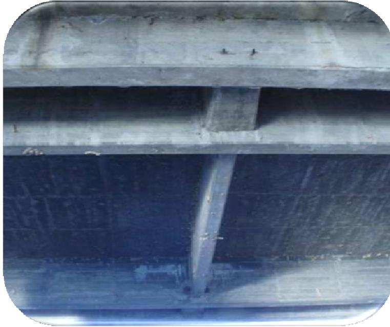
Fig.83 Se aprecian las manchas de humedad.
