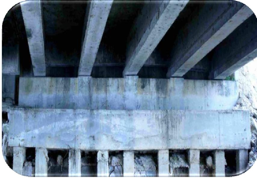
Fig.47 Vista general de cabezal desde estribo 6, donde se pueden observar las manchas por escurrimiento, así como fisuras de distintas longitudes.
