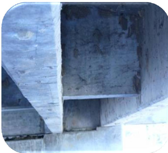
Fig.90 Se aprecian fisuras de distintas longitudes.
