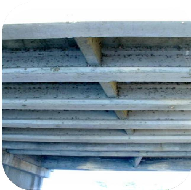
Fig.86 Se aprecian las manchas de humedad
