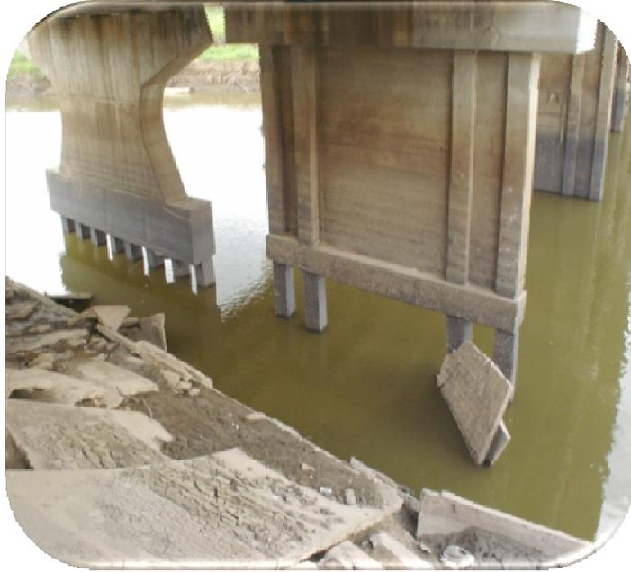
Fig. 69 Se observan problemas de socavación.
