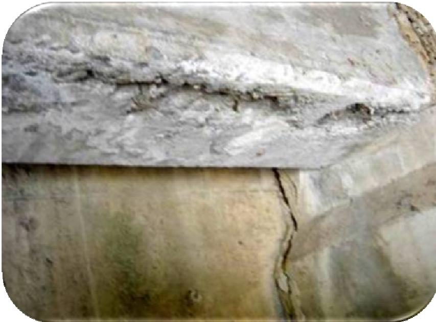
Fig. 40 Se presenta acero de refuerzo con un alto grado de corrosión y manchas de humedad.
