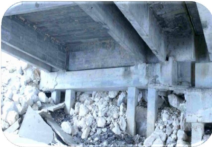
Fig.44 En el cabezal se observan manchas de humedad, desconche de material y cono de derrame dañado.
