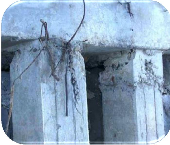
FIG.49 Vista de pilotes con acero expuesto con un alto grado de corrosión, fisuras, desprendimiento de material y una mala colada en la unión
