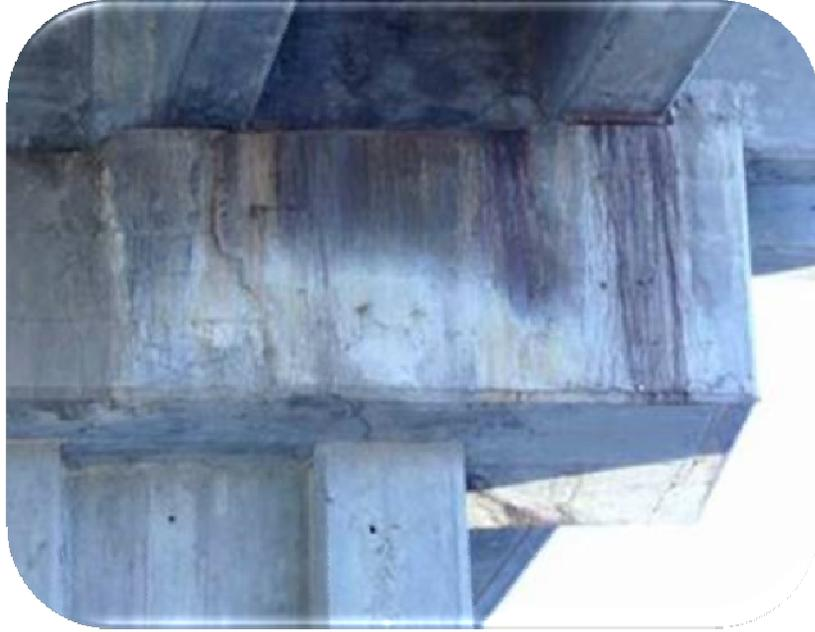
Fig. 63 Detalle de cabezal lado izquierdo donde se observan manchas de humedad y oquedades.
