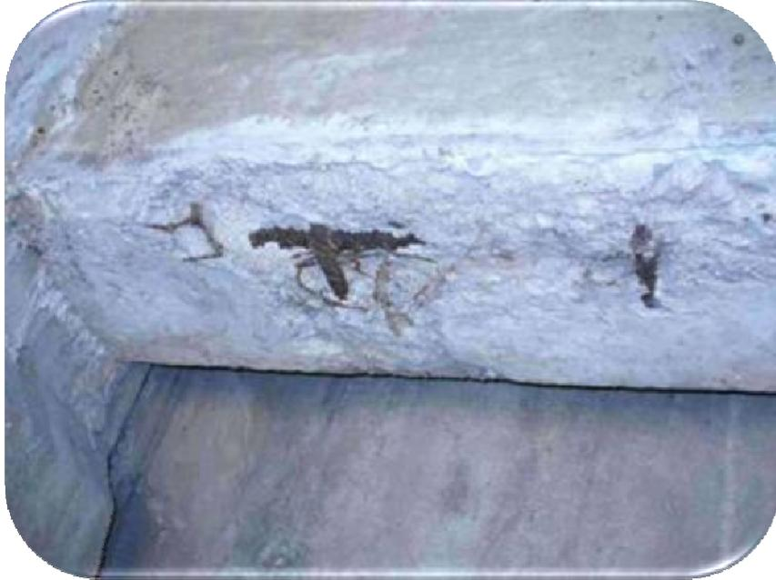
Fig. 37 Se observa desconche de material con acero de refuerzo expuesto en un alto grado de corrosión.
