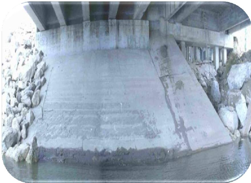
Fig. 30: Cabezal soportado por 4 pilotes de concreto reforzado, se observa que el cono de derrame ha sido dañado.
