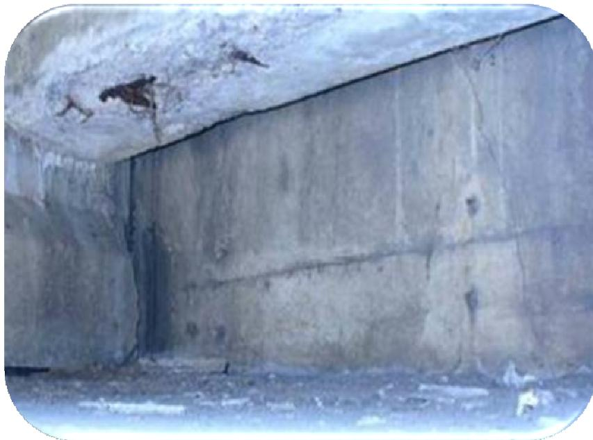
Fig. 36 El muro de respaldo presenta una fisura diagonal.
