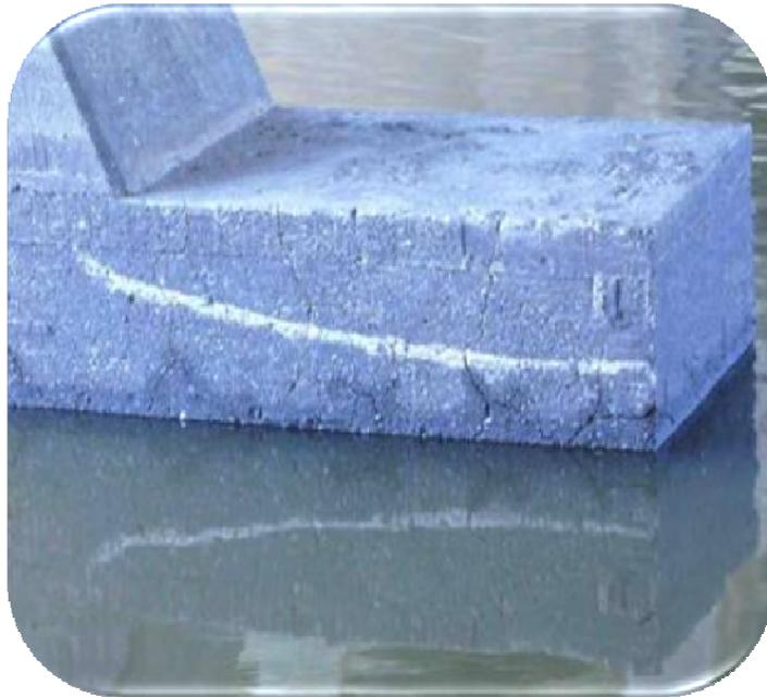
Fig. 70 Se observan fisuras de distintas longitudes en zapata "B" de pila eje 5.
