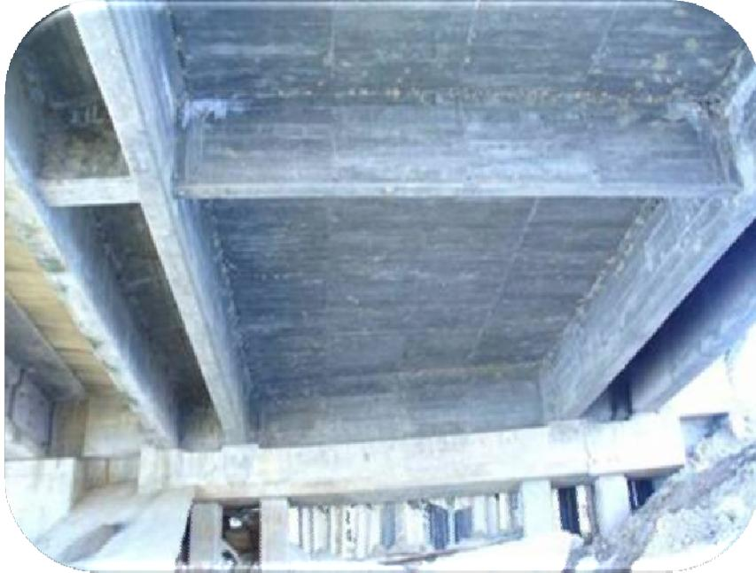
Fig. 33 El cabezal es de sección rectangular de 1.00x0.80x9.00 m, cuenta con un muro de respaldo, bancos de apoyo y topes sísmicos laterales.
