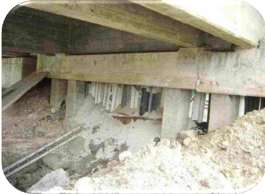
Fig. 31 Vista Lateral del Cono de derrame dañado
