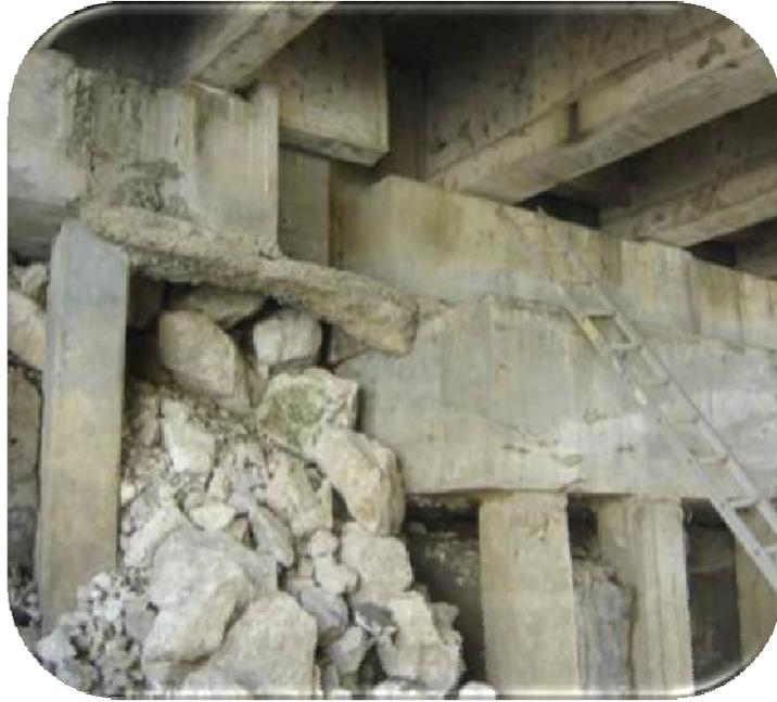
Fig. 45 Detalle del cabezal donde se observan, manchas de humedad, desconche y fisuras de distintas dimensiones.
