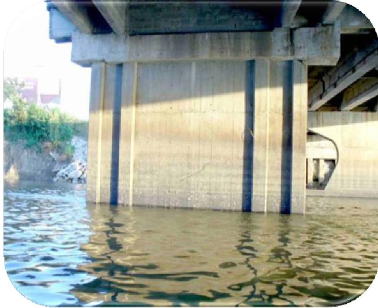
Fig. 65 Se ven manchas de humedad causadas por el escurrimiento que existe en la junta de dilatación en el cuerpo "A".
