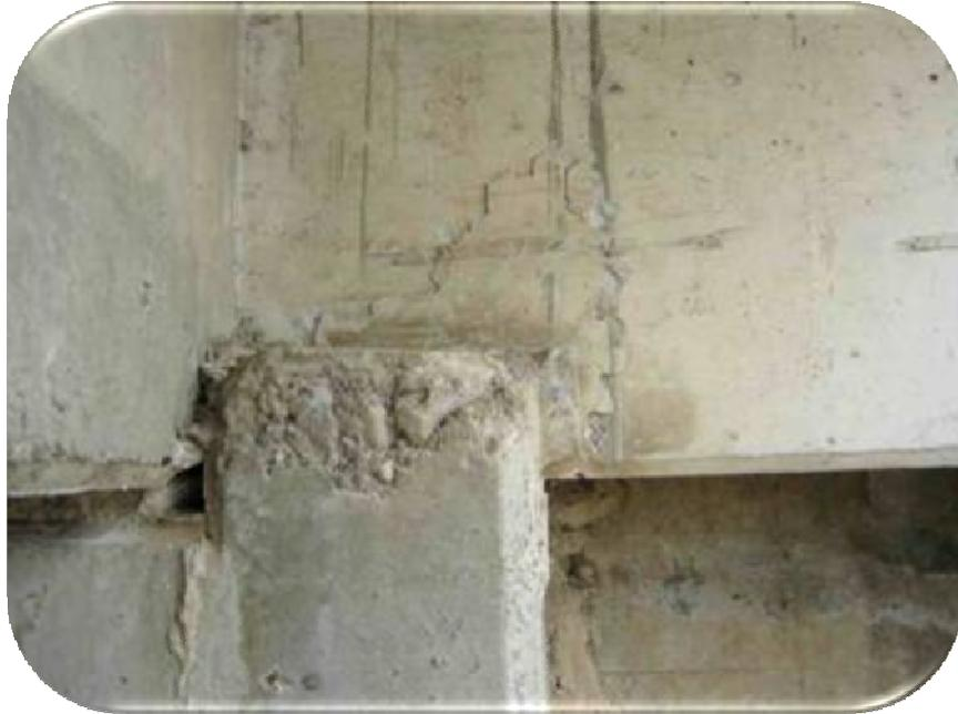
Fig. 35 Se muestra desconche en el tope sísmico.
