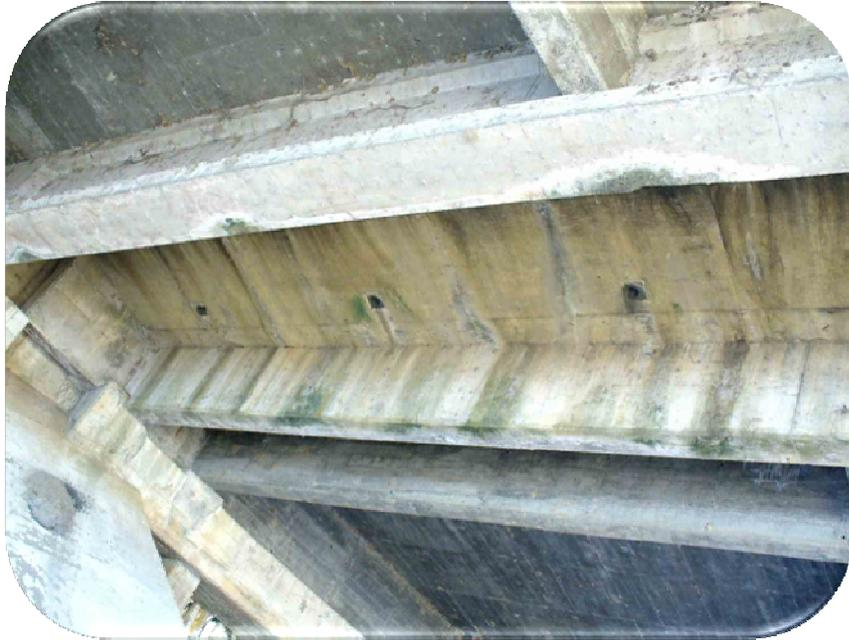
Fig. 75 Se observan drenes, fisuras y manchas de humedad.
