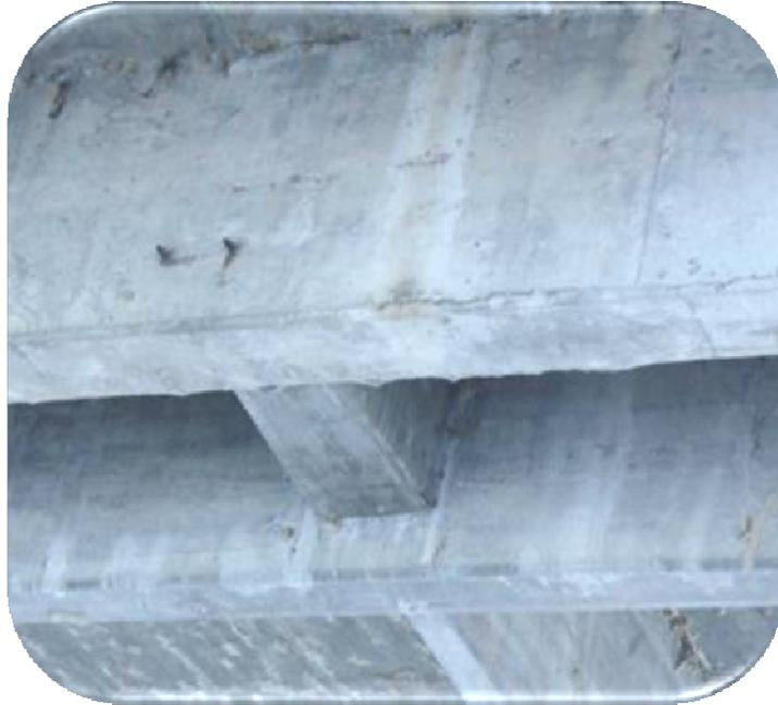
Fig.79 Se observa desconche de material con acero expuesto a corrosión
