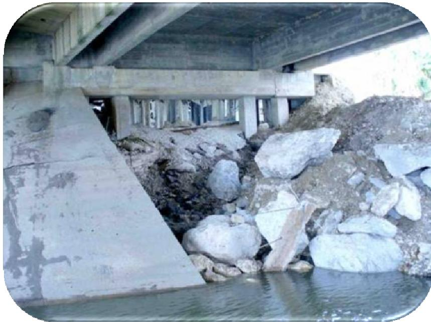
Fig. 32 Caballete Eje 1 Cuerpo "A": Esta conformado por un cabezal soportado por cuatro pilotes ambos de concreto reforzado, tras los pilotes se tiene una lámina que evita la pérdida de material que provoca asentamientos en el acceso.
