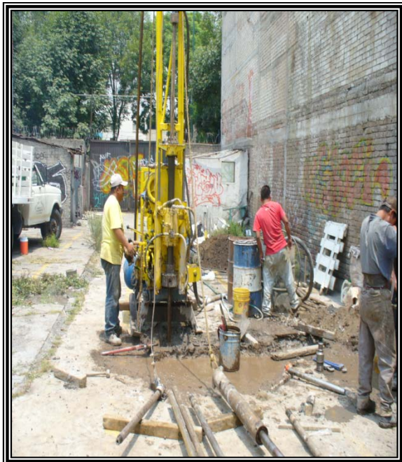
SE OBSERVA EL EQUIPO MECÁNICO QUE SE UTILIZÓ PARA EL SONDEO.
