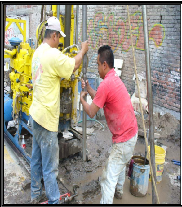
SE OBSERVA EL EQUIPO Y LA HERRAMIENTA PARA EL MÉTODO DE PENETRACIÓN ESTÁNDAR
