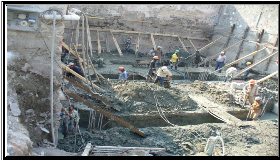
SE OBSERVA EL SISTEMA DE TROQUELAMIENTO
