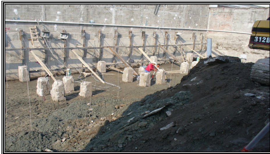
SE OBSERVA LA PROTECCIÓN DE LAS COLINDANCIAS Y LOS PILOTES
