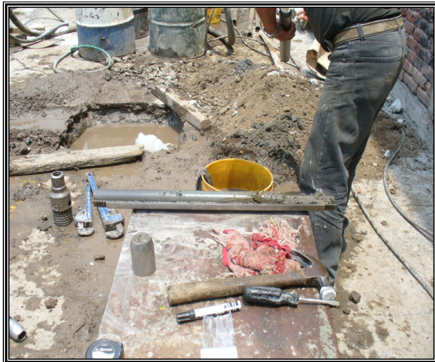
SE OBSERVA LA OBTENCIÓN DE LA MUESTRA CON EL TUBO DE PARED DELGADA.
