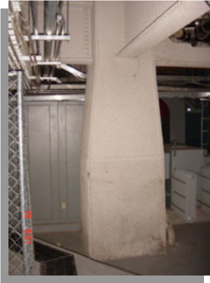
Detalle de reducción de columnas
