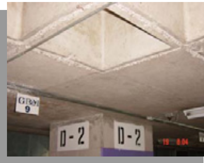
Losa de sótano
