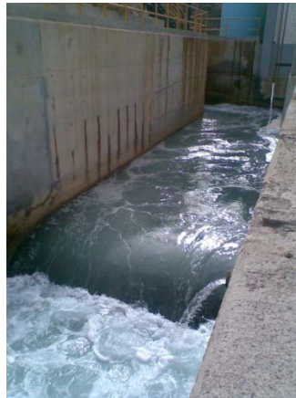
Figura 7: Canal de llamada de planta termoeléctrica
