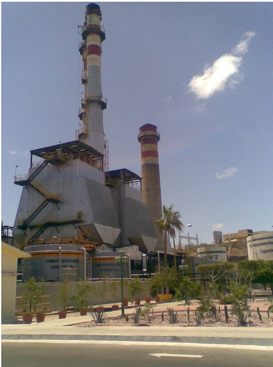
Figura 2: Planta Termoeléctrica Punta Prieta - Pichilingue
