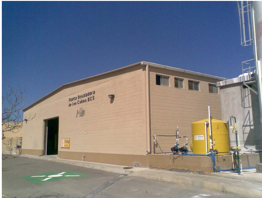
Figura 1: Planta desaladora de Los Cabos B.C.S. (Cortesía de INIMA Desalación)
