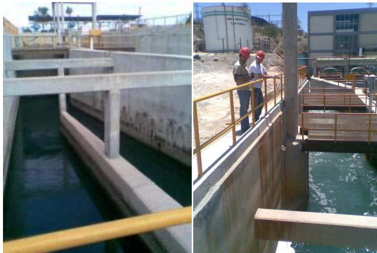
Figura 1: Obra de toma y descarga de planta termoeléctrica para enfriamiento de condensadores
