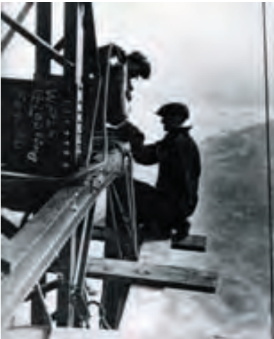
Fig. 1m Operarios del acero sobre el Empire State Building, Nueva York, Lewis Wickes Hine
