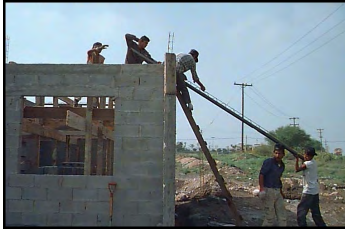
FIGURA 18. Colocación de Viguetas Alma abierta.
