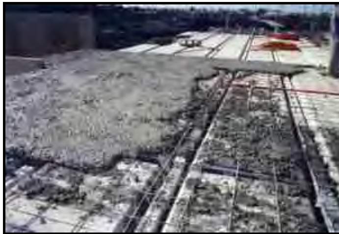
FIGURA 24. Capa de Compresión
