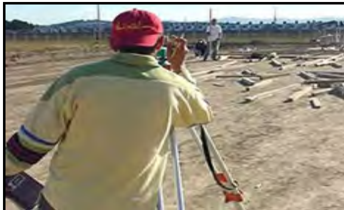
FIGURA 27. Trazo y Nivelación del Terreno
