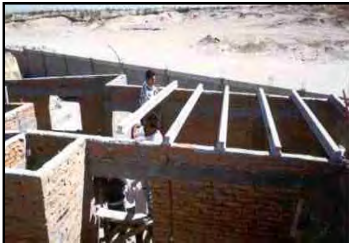
FIGURA 19. Montaje de Viguetas Pre-tensadas.
