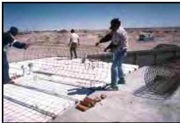
FIGURA 23. Colocación de malla soldada.
