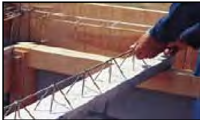
FIGURA 1. Vigueta de alma abierta
