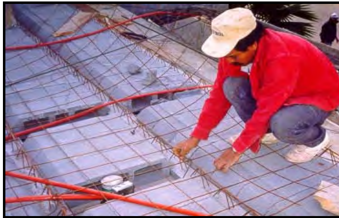
FIGURA 14. Colocación de Acero de Refuerzo.
