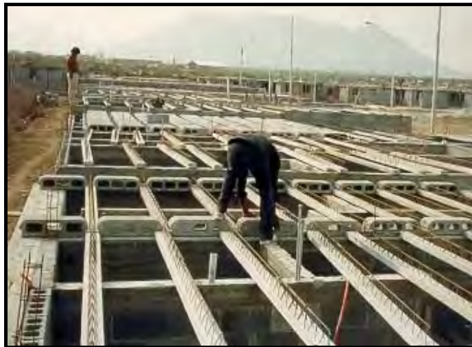
FIGURA 22. Colocación de Bovedilla
