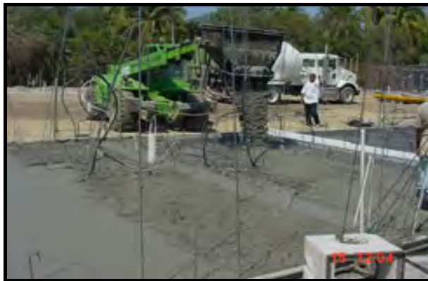
FIGURA 31. Colado de Cimentación
