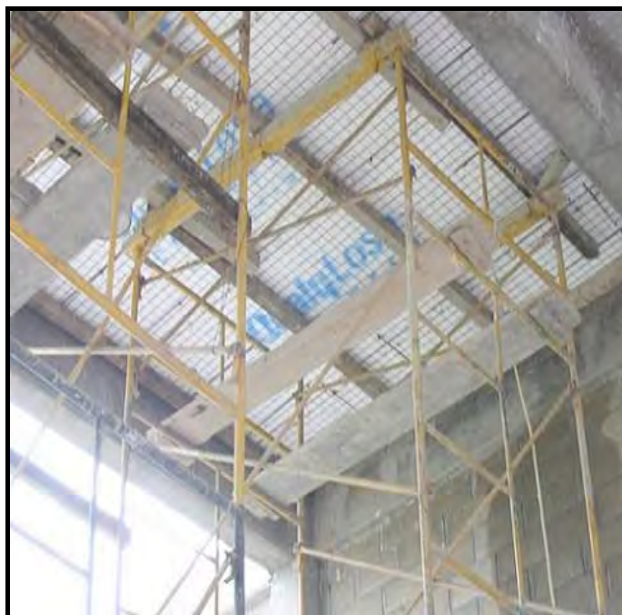
FIGURA 68. Apuntalamiento de los Paneles de losa.
