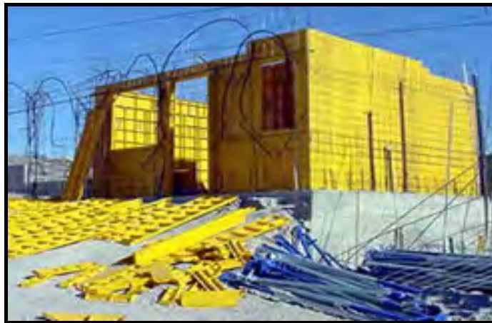
FIGURA 33. Cimbra para Muros.
