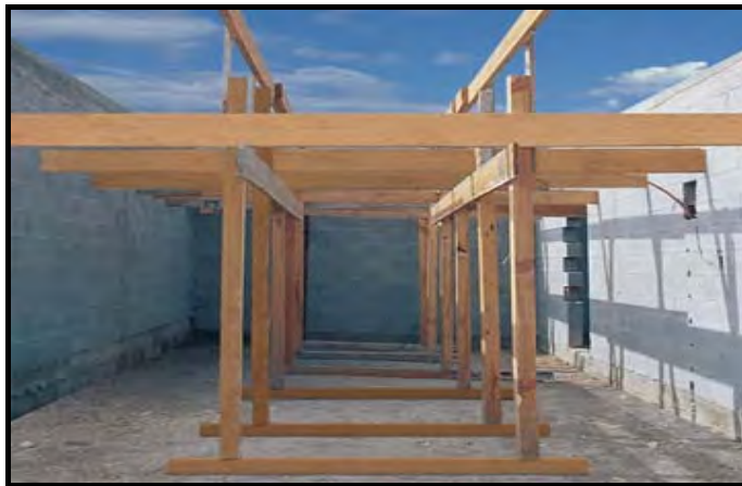
FIGURA 17. Apuntalamiento para viguetas de alma abierta.
