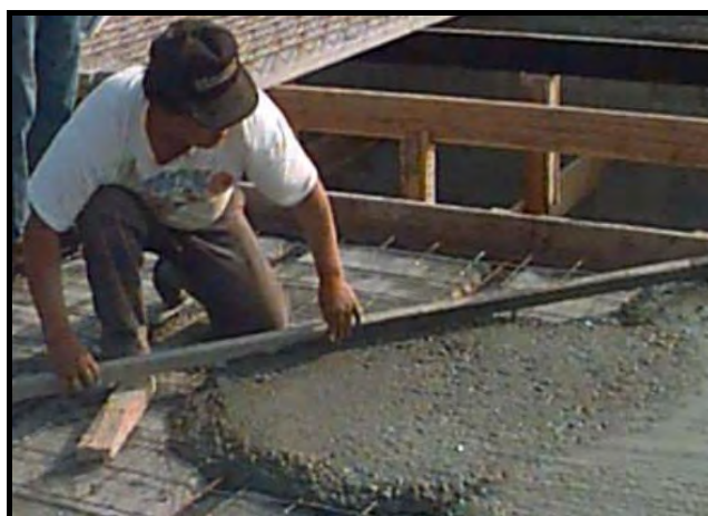
FIGURA 15. Colocación de Capa de Compresión
