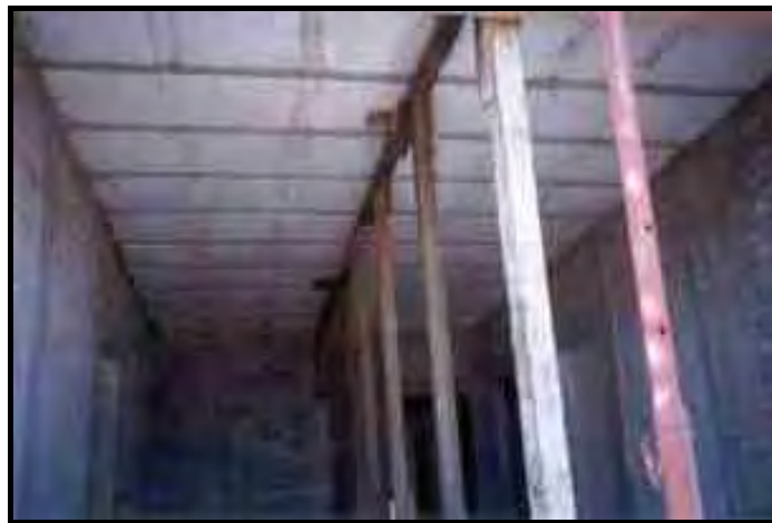
FIGURA 20. Cimbra para viguetas pre-tensadas.
