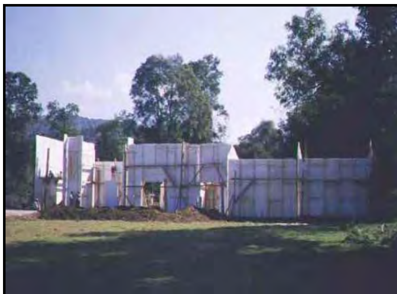
FIGURA 63. Levantamiento de Muros con Paneles Covintec.
