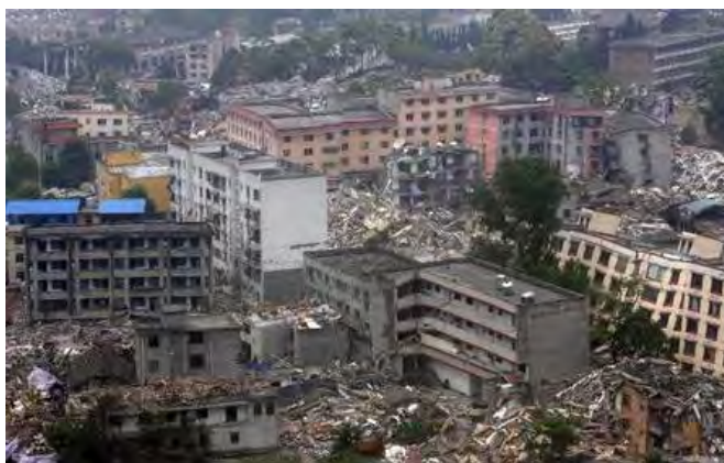
Figura 1.1 Colapso de escuelas y edificios departamentales, sismo Sichuan (2008)
