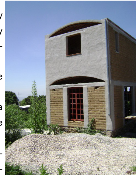
Casa adobe. Arq. César Añorve
