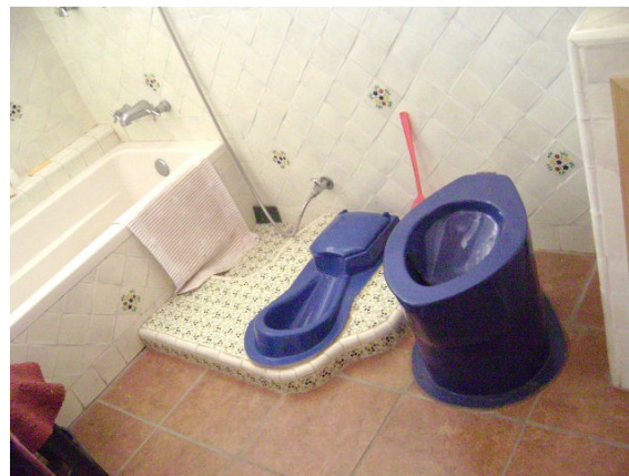
Sanitario seco, Casita de miel, Arq. César Añorve
