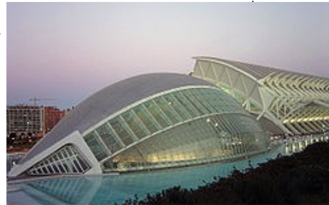
Cine-Planetario, Santiago Calatrava
