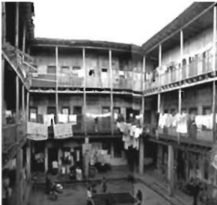
INMUEBLE ANTES DE LA REHABILITACIÓN. FUENTE: MINVU. Proyecto Población Obrera De La Unión, Cerro Cordillera, 2005 Valparaíso.
