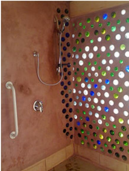
FOTO 10 y 11: Interior de casa ecológica, se muestran materiales de origen natural en la foto 10, tales como pisos de barro y techos de madera, y en la foto 11 se muestra el uso de botellas de vidrio recicladas, como decoración y usándolas para iluminar el espacio. Tomada de <http://www.bioarquitectura.20m.com>
