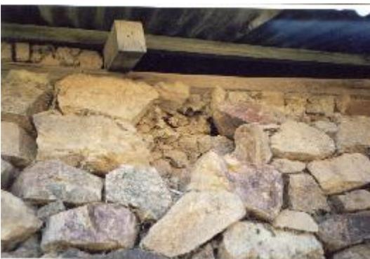
FOTO 7 y 8: Materiales usados en la bioconstrucción, son materiales encontrados en el lugar y sin procesos artificiales, por lo que no contaminan. Tomada de <http://www.bioarquitectura.20m.com>
